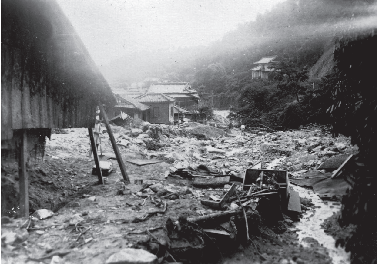
図 24 阪神大水害直後の川崎美術館（阪神大水害デジタルアーカイブより転載）
