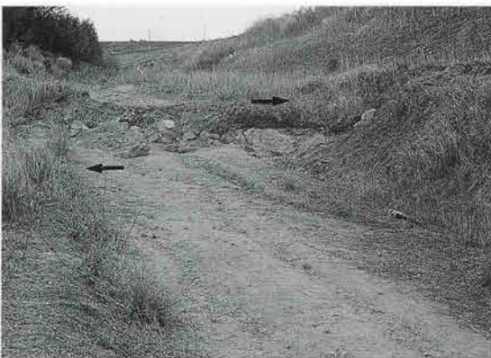
写真1 野島断層の活動による道路の変位(平林地区)
