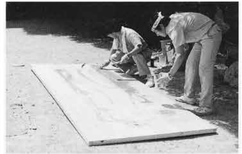
図202 パネルに接着剤を塗る
