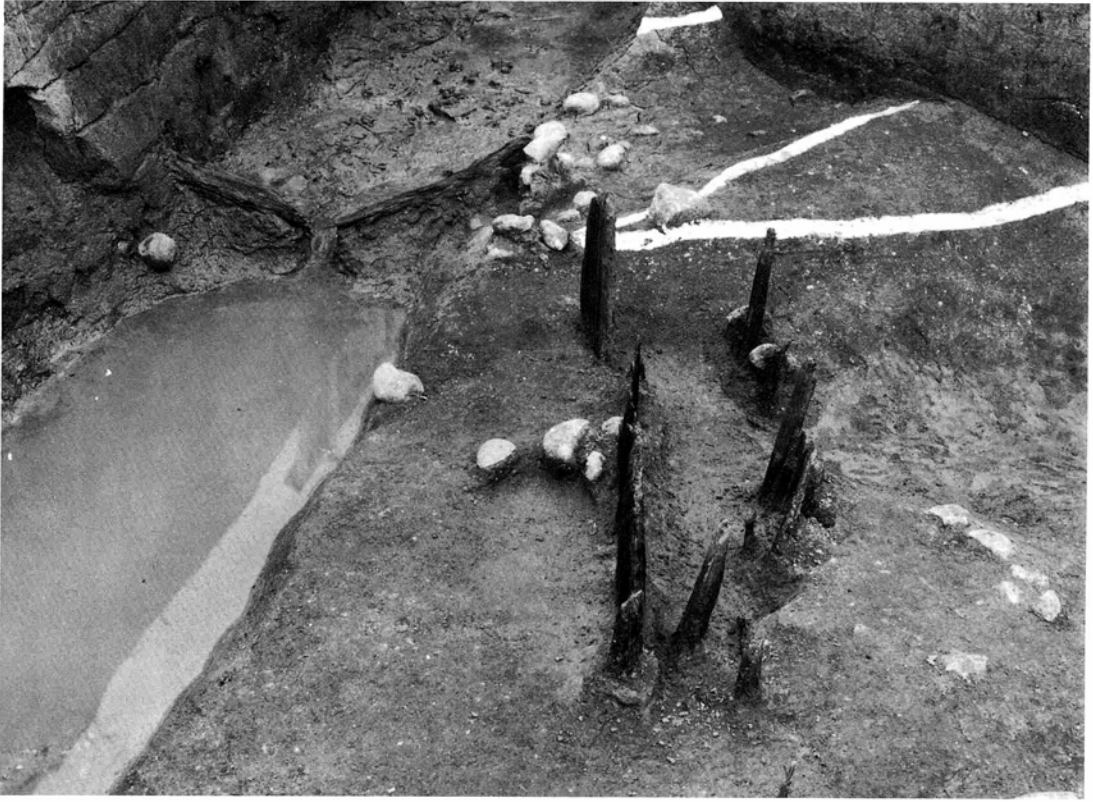
1. 溝10井堰 (北から)
