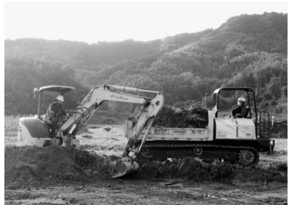
写真 1 重機による表土除去
