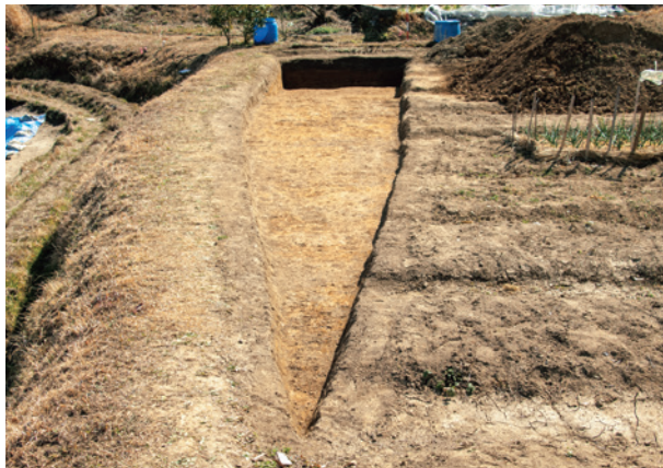
5 2地区上段トレンチ掘削状況（北から）
