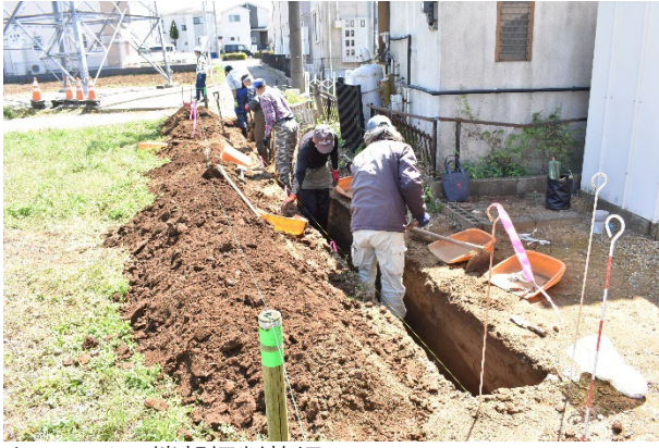
トレンチ西端部掘削状況
