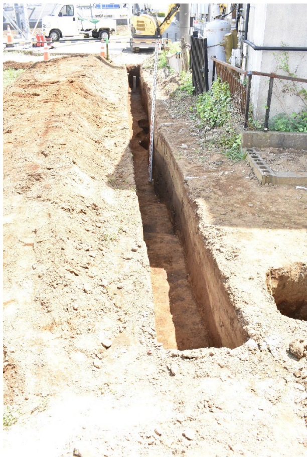
トレンチ西部完掘状況
