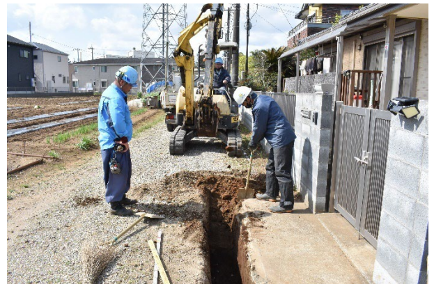
トレンチ北西部掘削状況
