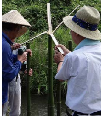
水棚づくりの手順1 5本の竹で骨組みをつくる。
