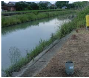
花火発射台設置
