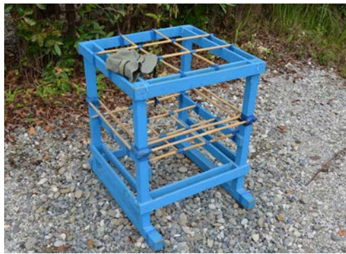
ショウブ小屋の基礎作り
