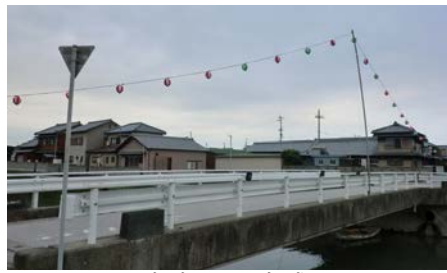
提灯設置完成
