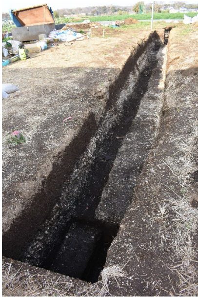
1:Aトレンチ 完掘状況
