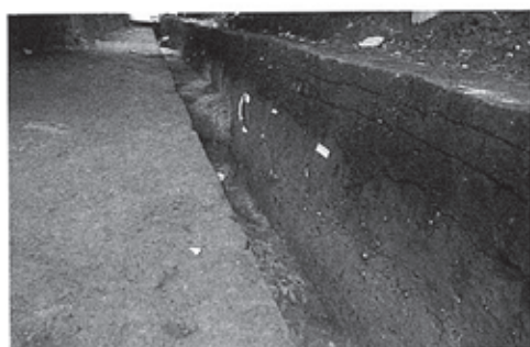
東西トレンチ (西側より)
