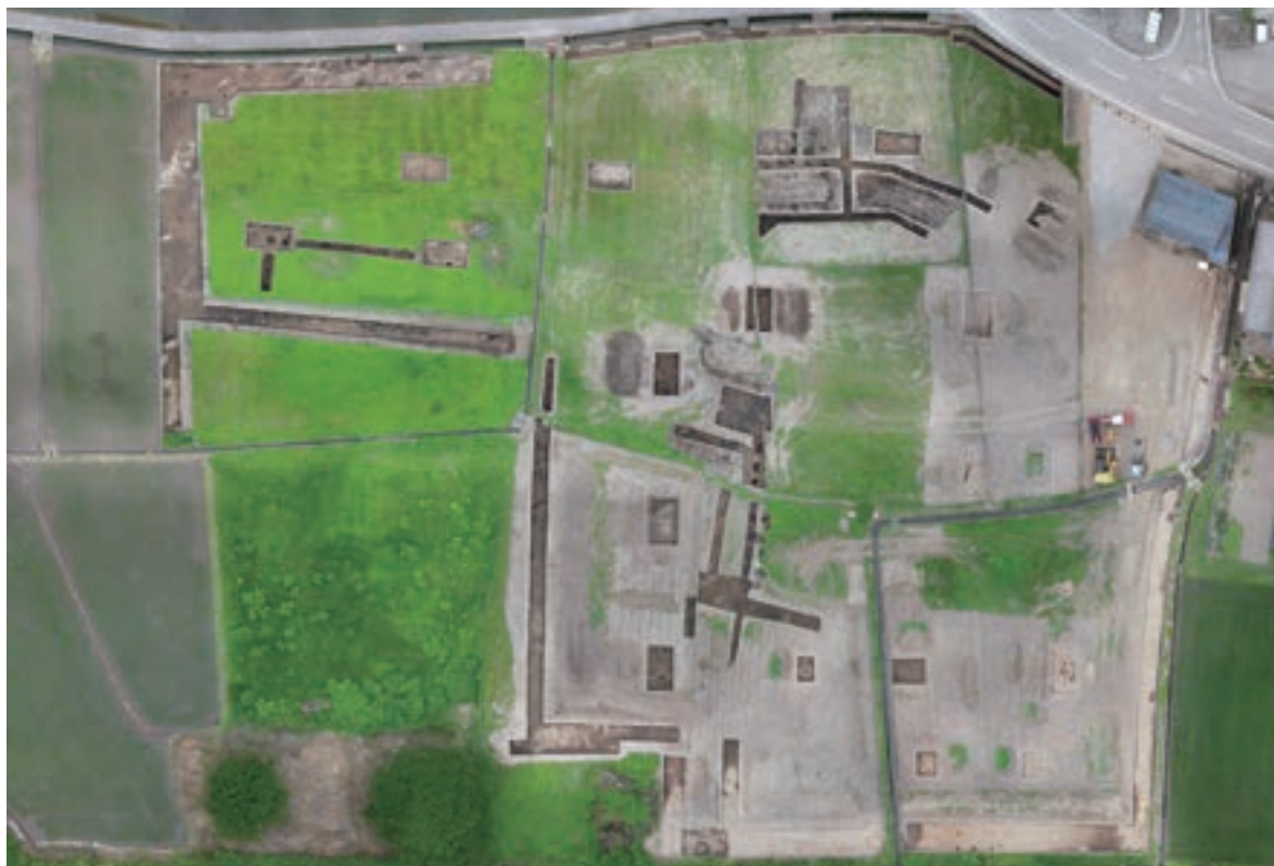
調査区全景（俯瞰）
