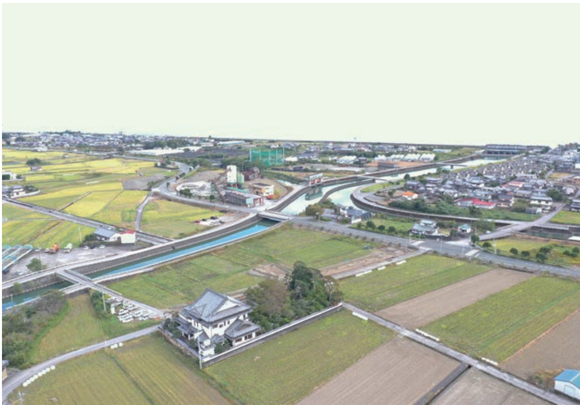
調査地遠景（北西から）
