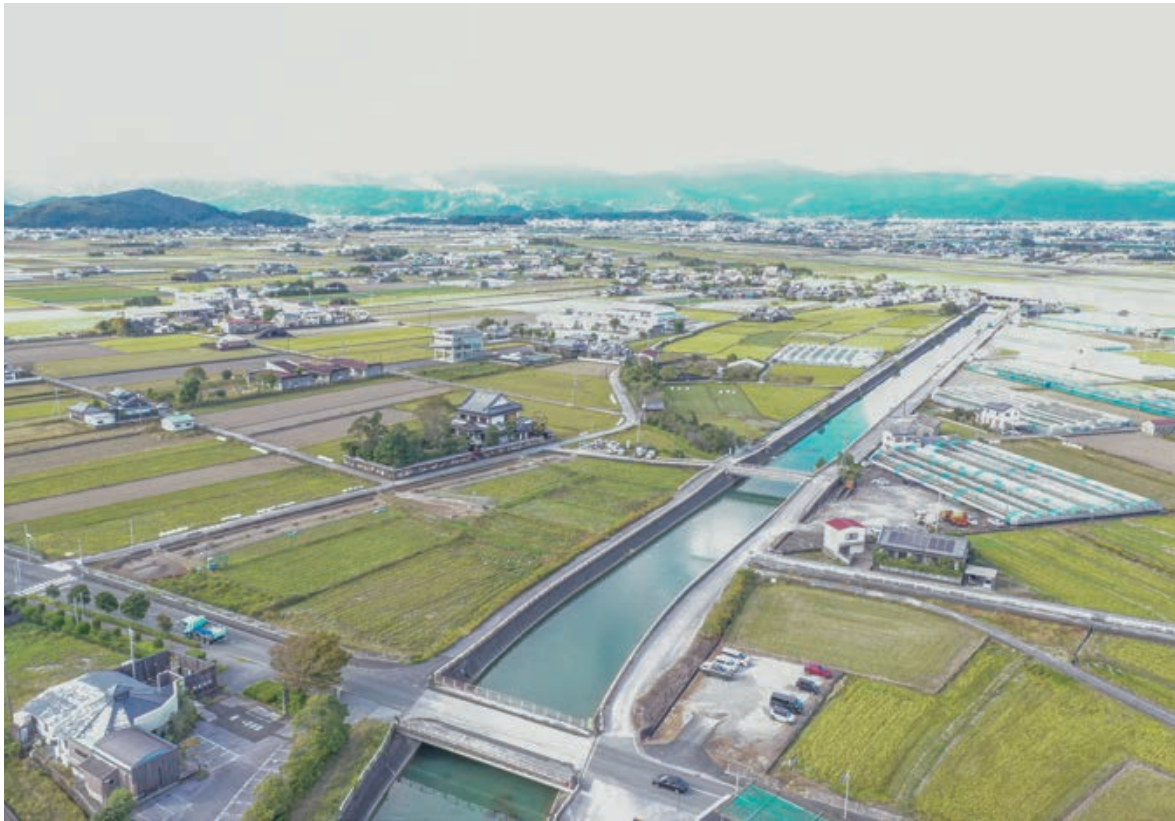
調査地遠景（南東から）
