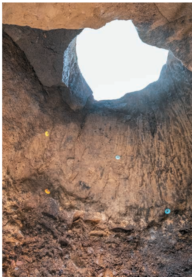
同 羨道天井 掘削痕
