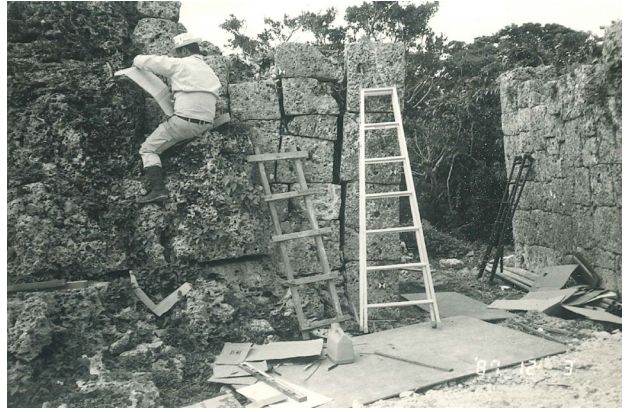
図版 10. 正門修復前（城外 南東側より）
