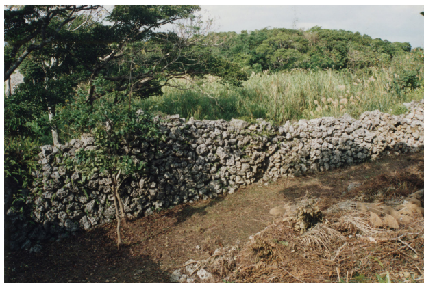
図版 89. 城壁修復工事着工前（東側より）
