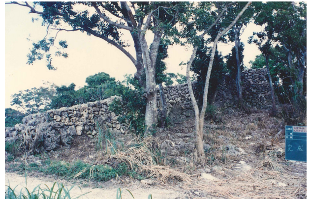
図版 52. 城壁修復工事竣工（北東側より）
