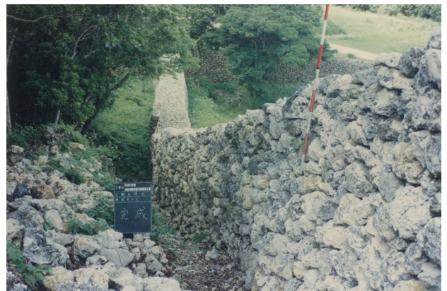
図版 102. 城壁修復工事竣工（北東側より）
