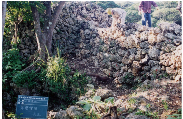
図版 56. 城壁積直し状況（北東側より）
