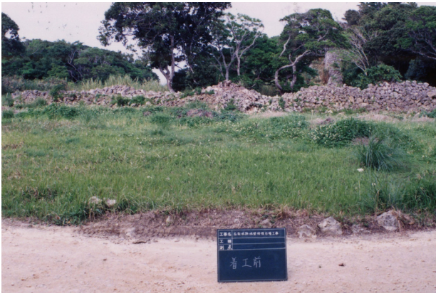
図版 55. 城壁修復工事着工前（南西側より）
