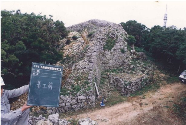
図版 107. 城壁修復工事着工前（南側より）
