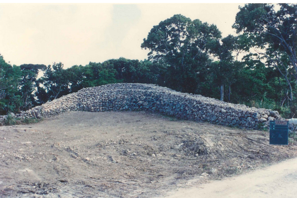
図版 53. 城壁修復工事竣工（南側より）
