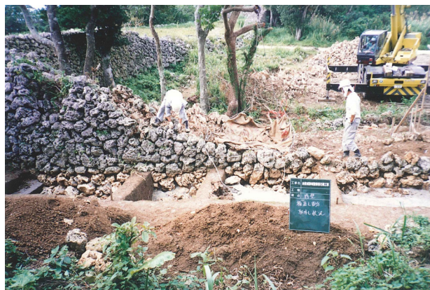
図版 90. 城壁積み直し状況（東側より）
