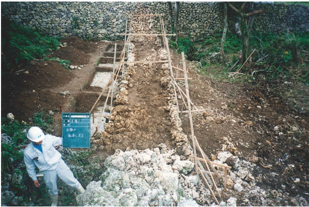
図版 91. 城壁積直し状況（北東側より）
