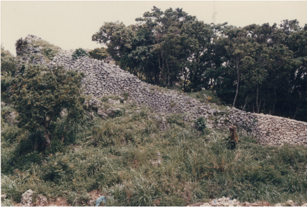
図版 97. 城壁修復工事着工前（西側より）
