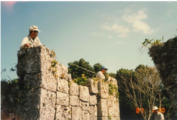
図版 5. 測量箇所（正門北側 南側より）
