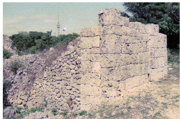
図版 20. 工事竣工状況（城内 南西側より）
