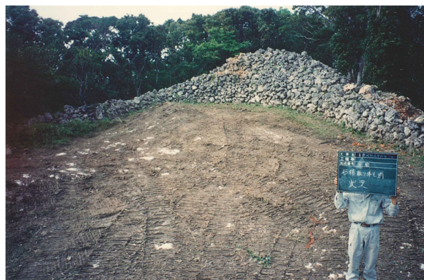
図版 48. 城壁修復工事着工前（南側より）
