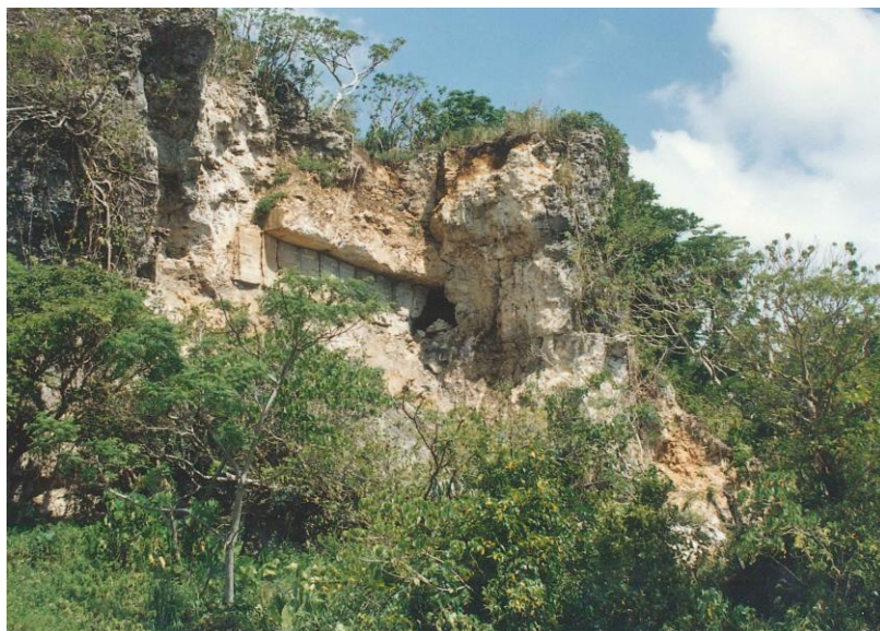
図版 2. 斜面崩落箇所近景（西側より）
