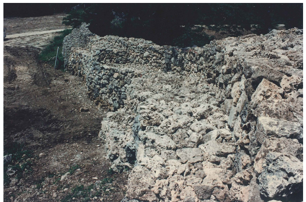
図版 86. 城壁修復工事竣工（南東側より）
