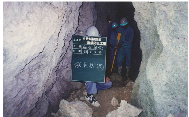
図版 64. 調査状況 (洞窟内区域)
