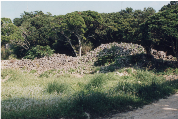
図版 83. 城壁修復工事着工前（南西側より）
