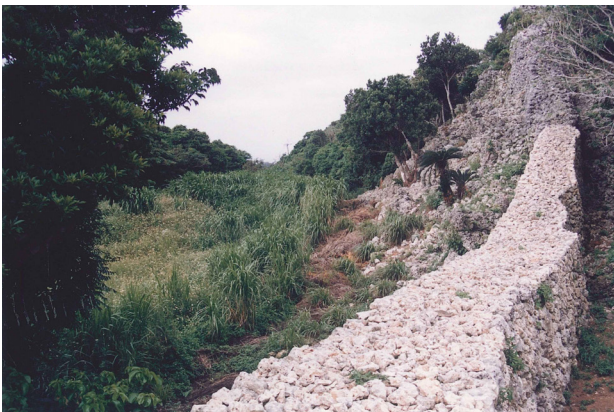
図版 95. 城壁修復工事竣工（南西側より）
