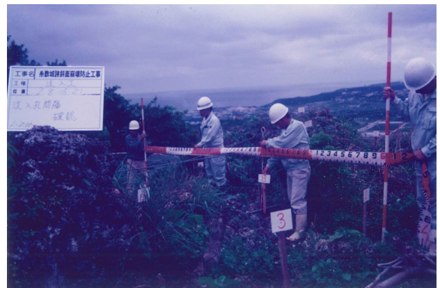
図版 80. 地盤改良工注入口間隔確認
