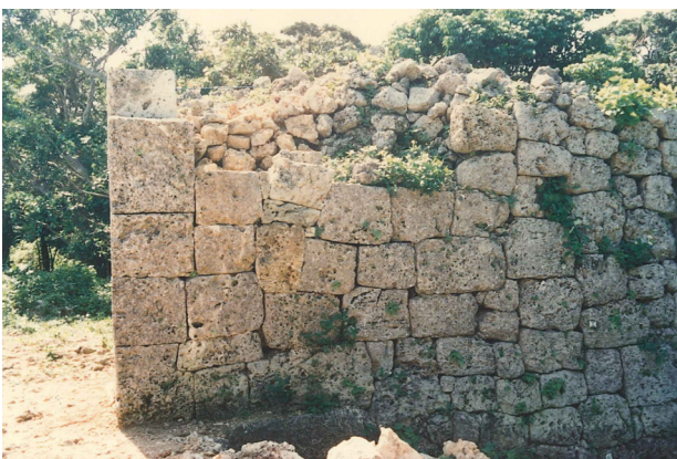
図版 19. 工事竣工状況（城外 東側より）
