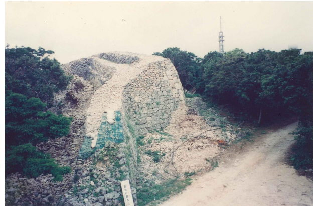
図版 108. 城壁修復工事竣工（南側より）
