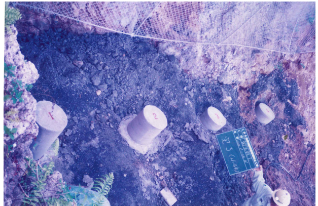
図版 72. 抑止杭工完了
