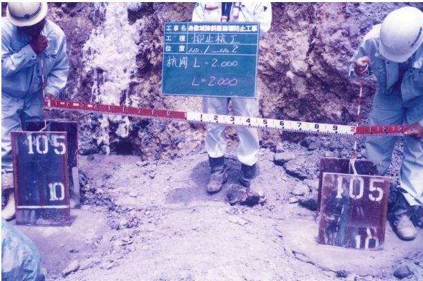
図版 71. 杭間確認
