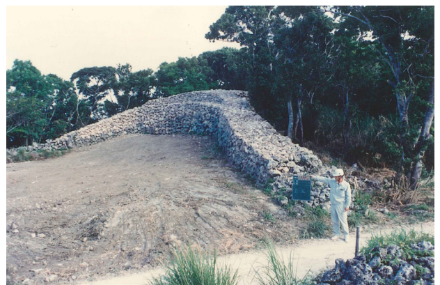
図版 54. 城壁修復工事竣工（南東側より）
