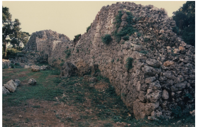
図版 24. 測量箇所 (城外正門北側 北側より)
