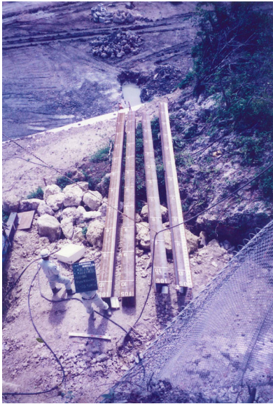
図版 67. 材料検収 (H型鋼)
