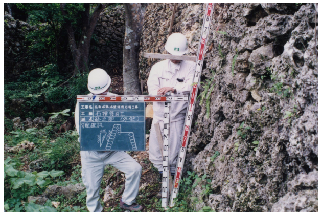
図版 58. 城壁勾配確認状況（北西側より）
