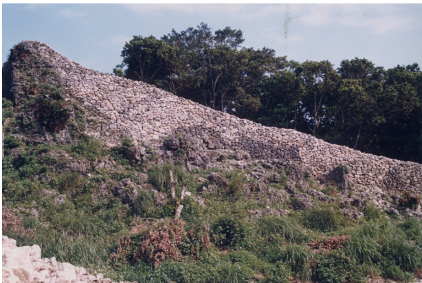
図版 101. 城壁修復工事竣工（西側より）
