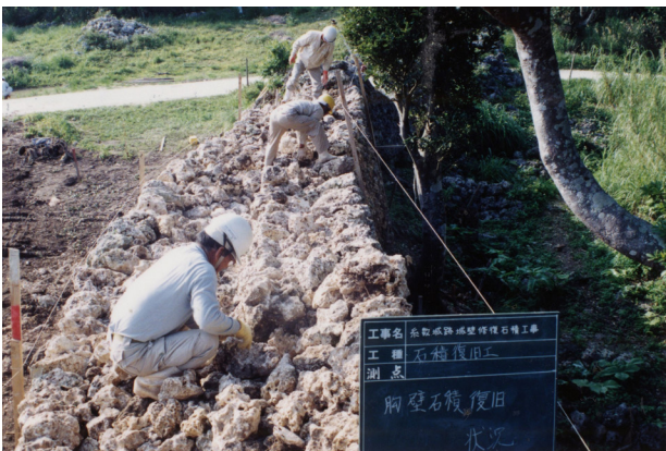
図版 57. 城壁積直し状況（南東側より）
