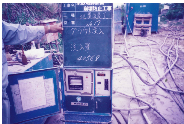
図版 81. グラウト注入
