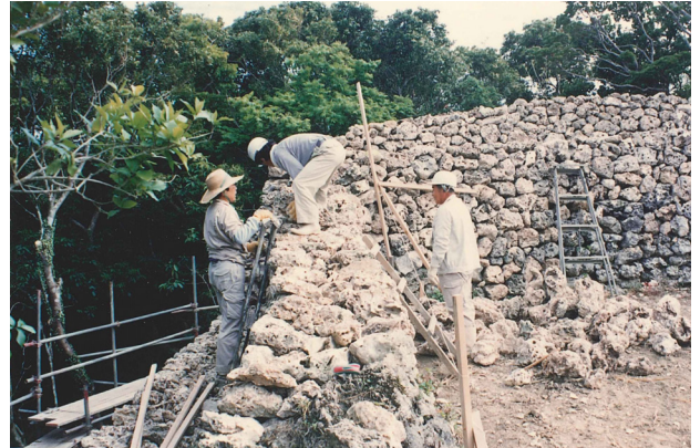
図版 50. 城壁積直し状況（南西側より）
