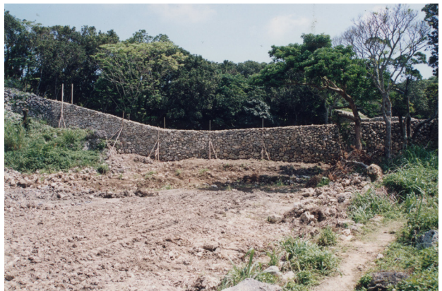
図版 96. 城壁修復工事竣工（北西側より）
