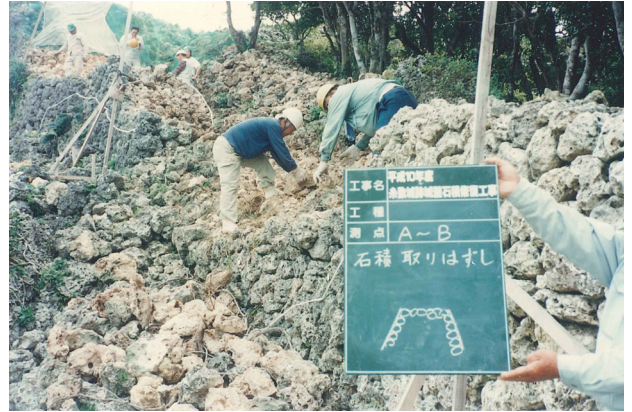
図版 98. 城壁積直し状況（南西側より）
