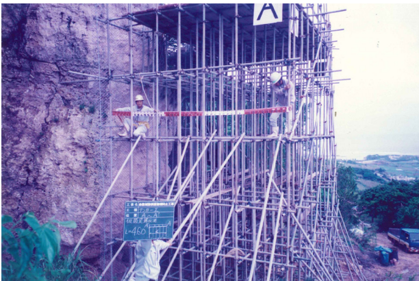
図版 73. アンカー工仮設足場設置
