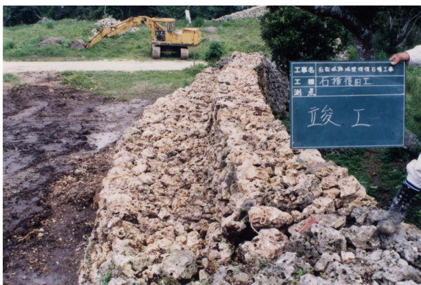
図版 59. 城壁修復工事竣工（南東側より）
