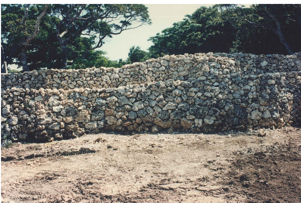
図版 87. 城壁修復工事竣工（南西側より）
