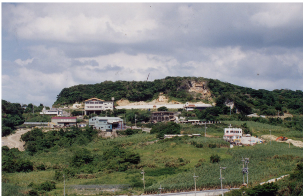
図版 61. 斜面崩落箇所遠景 (南西側より)
