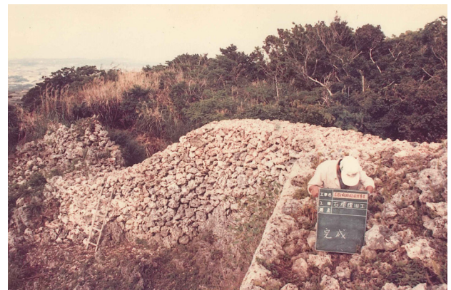
図版 46. 城壁修復工事竣工（北東側より）
