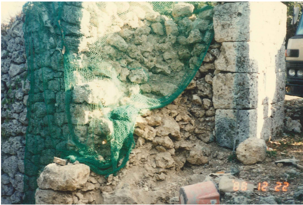
図版 15. 正門修復工事（城内 南西側より）
