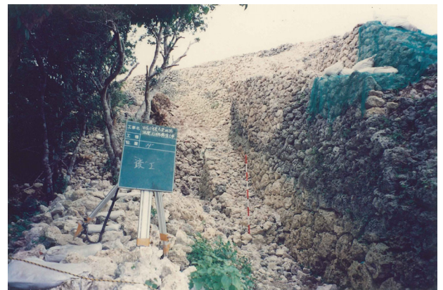
図版 112. G 付近城内側竣工（南側より）
