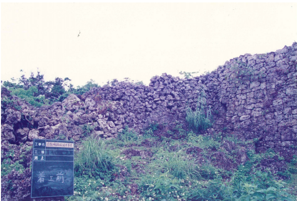
図版 43. 城壁修復工事着工前（東側より）
