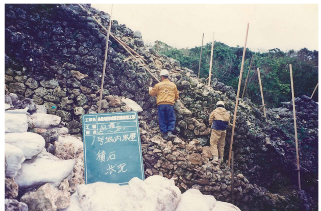
図版 104. E'～F' 城内側積石状況（西側より）
