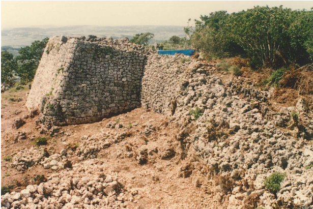
図版 11. 測量箇所（南のアザナ 北側より）
