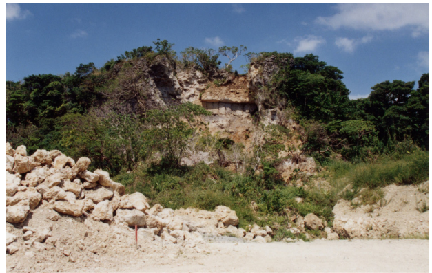
図版 62. 斜面崩落箇所 (南西側より)
