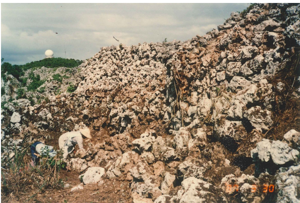
図版 13. 城壁露出作業（D地区 南側より）
