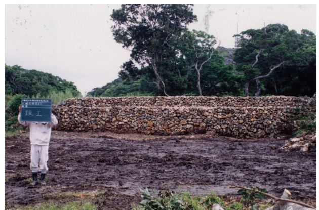
図版 60. 城壁修復工事竣工（南西側より）
