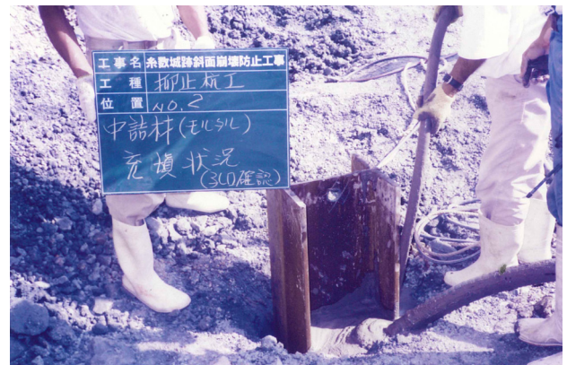
図版 70. モルタル充填状況
