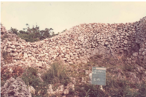
図版 45. 城壁修復工事竣工（東側より）
