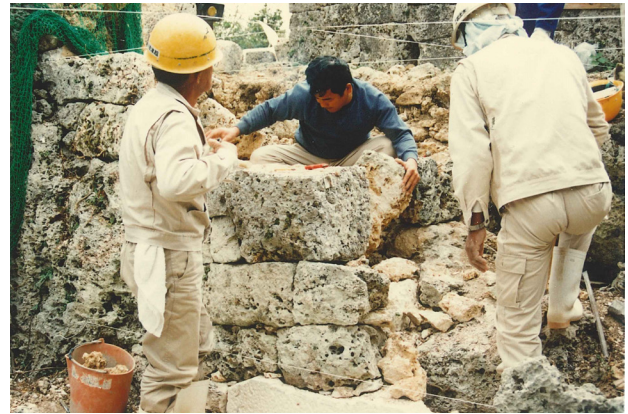
図版 16. 正門修復工事（城内 南西側より）
