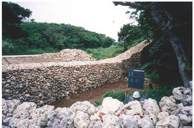
図版 94. 城壁修復工事竣工（南側より）
