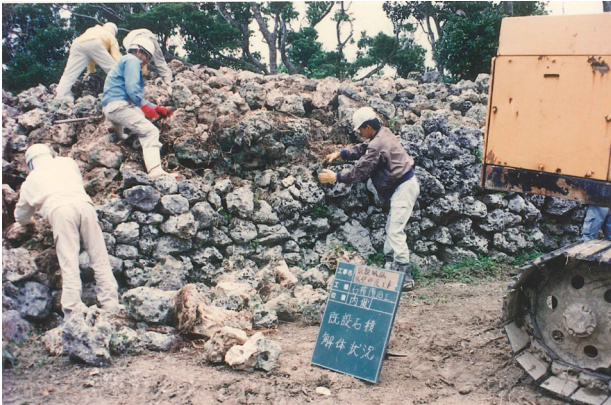
図版 49. 城壁解体状況（南側より）
