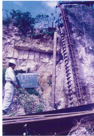
図版 68. H型鋼建込状況
