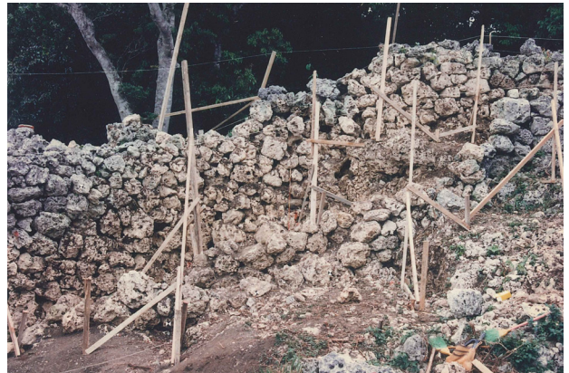
図版 84. 城壁積直し状況（南西側より）
