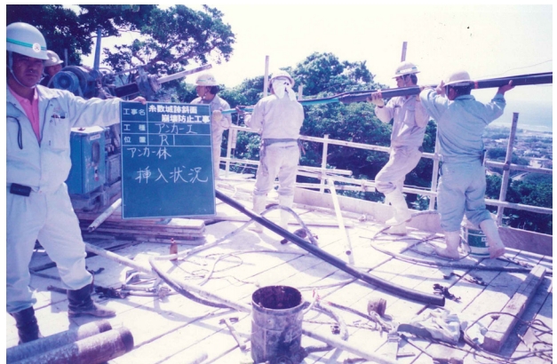
図版 74. アンカー体挿入状況
