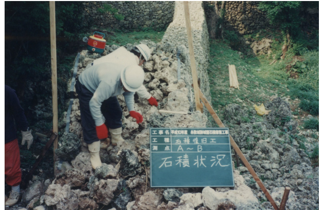
図版 100. 城壁積直し状況（北東側より）
