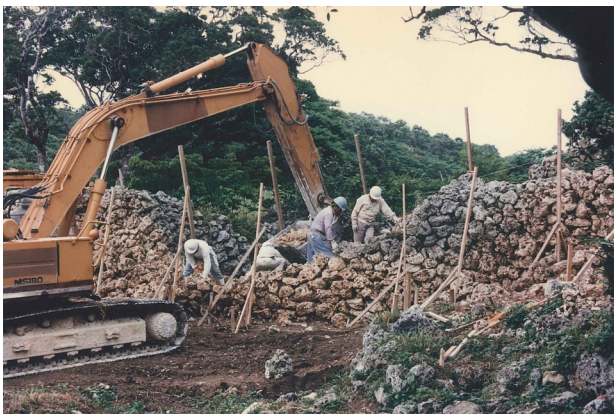
図版 85. 城壁積直し状況（南側より）
