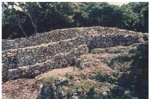
図版 88. 城壁修復工事竣工（南西側より）
