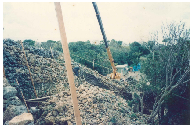
図版 106. A～H クレーン使用状況（北側より）
