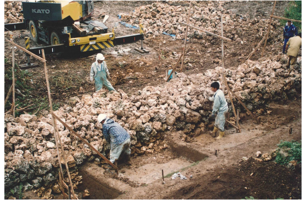
図版 92. 城壁積直し状況（南側より）
