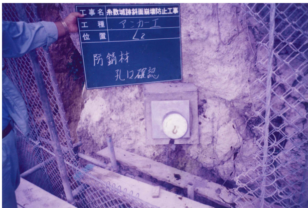
図版 79. 防錆材孔口確認
