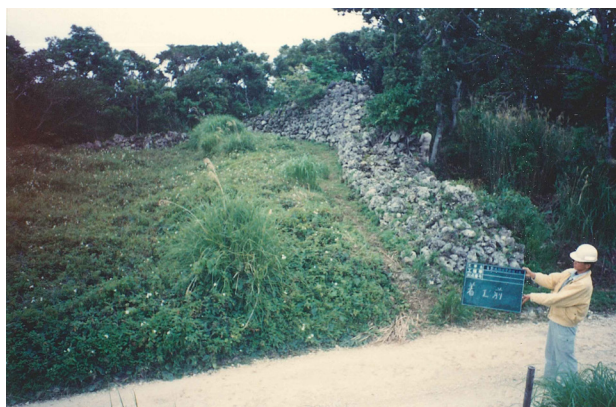
図版 47. 城壁修復工事着工前（東側より）
