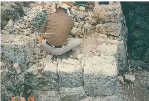
図版 17. 正門修復工事（南側より）
