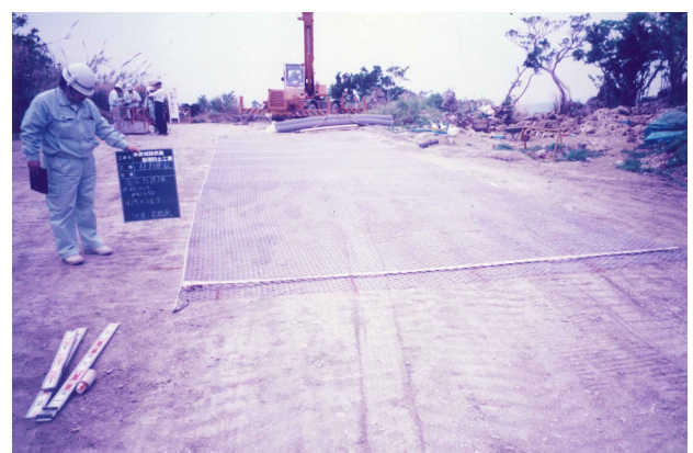
図版 82. 材料検収 (転落防護網)
