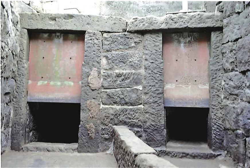
分水樋門（北から）
