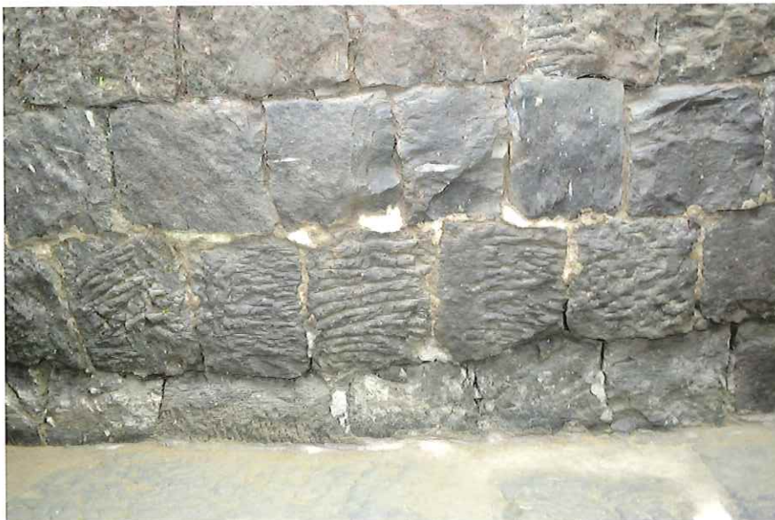
1号水路南端部東壁面下部
