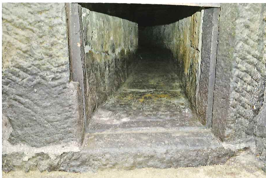
3号水路（北から）
