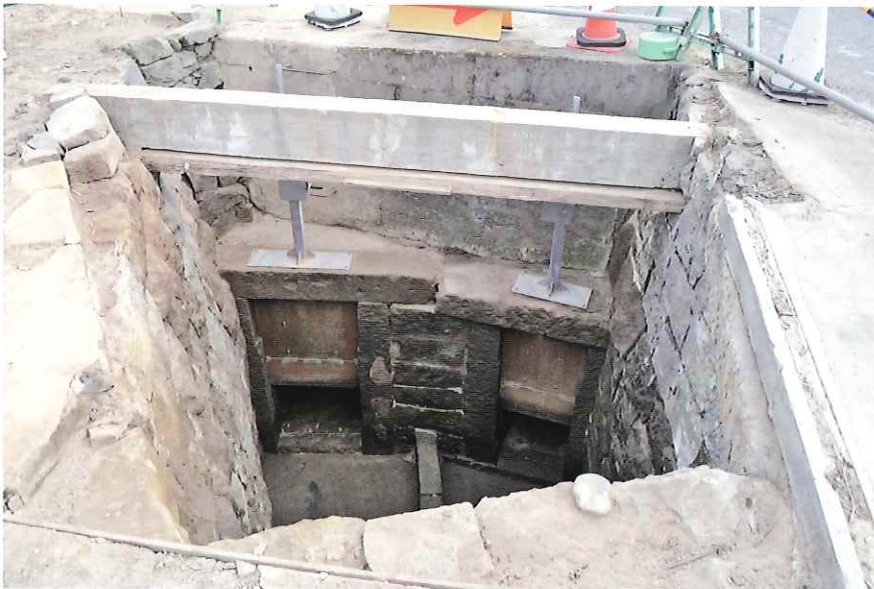
1号水路南端部 (北から)
