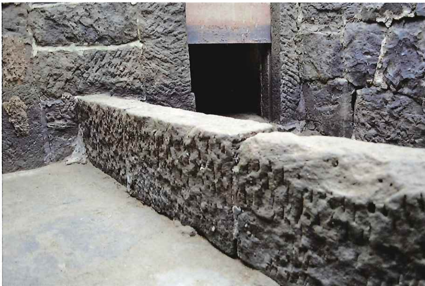
1号用水路南端部水路仕切石 （東から）
