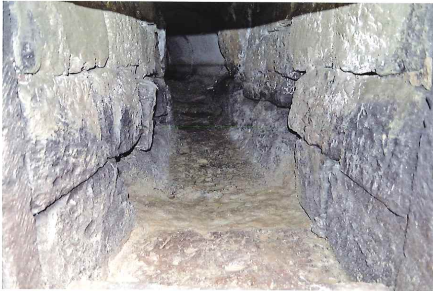
2号水路（北から）
