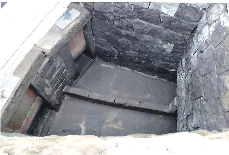
1号水路南端部 (東から)
