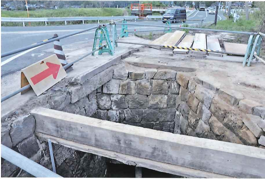
1号水路南端部建物除去後 (南から)
