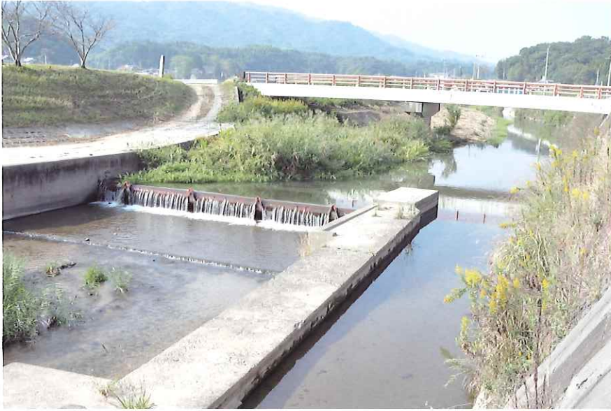
船島堰と導水路（南から）
