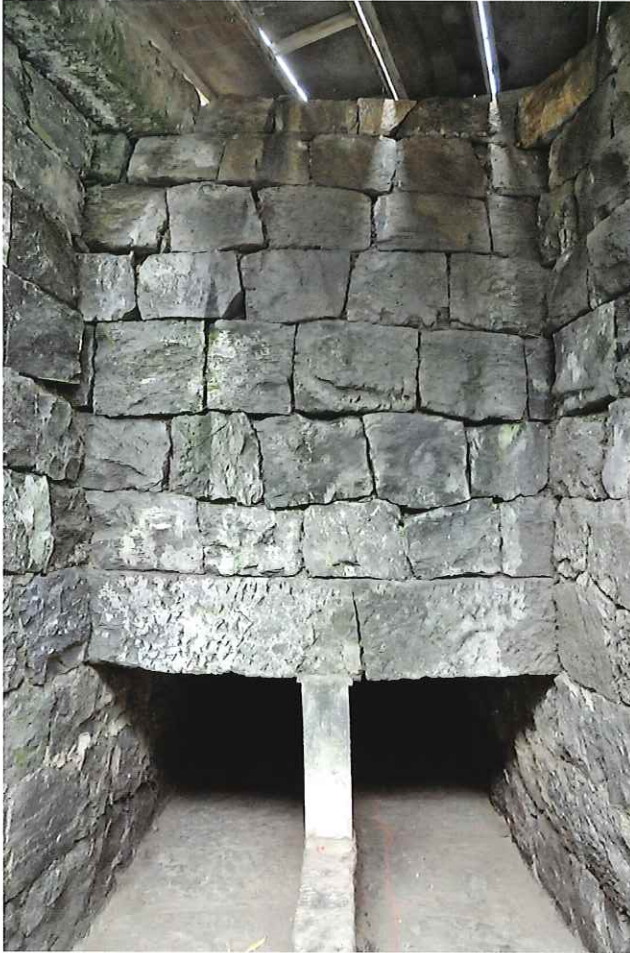
1号用水路南端部北壁面
