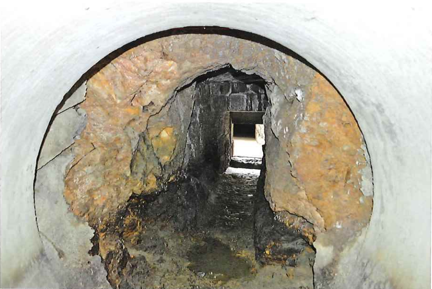
2号水路②（南から）
