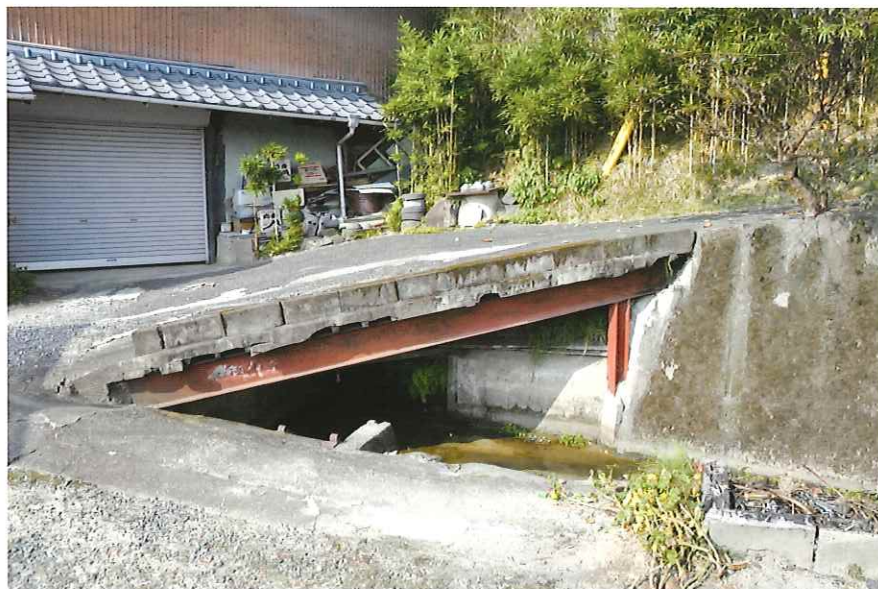
3号用水路南端部（南から）
