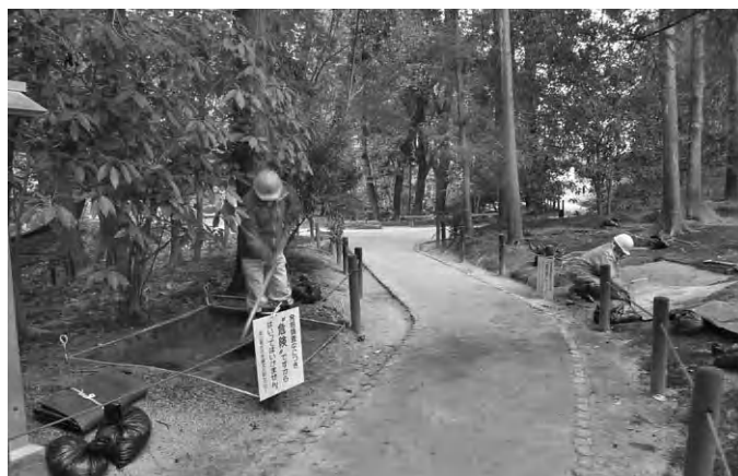
2 T18・T19作業風景 (南西から)
