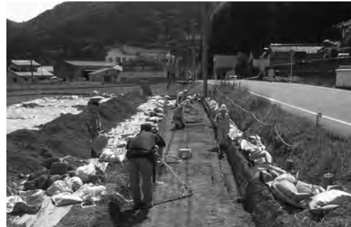
写真1 作業風景1（北東から）
