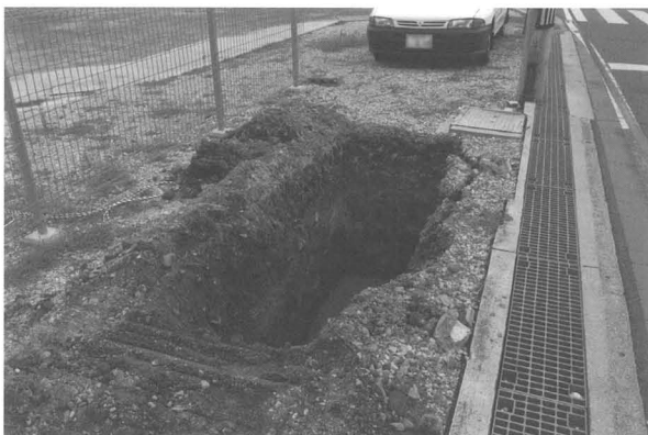
写真8 調査区2掘削状況（北西から）
