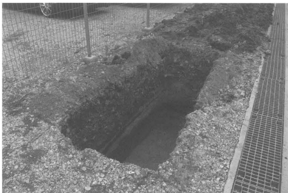
写真4 調査区1掘削状況（北西から）
