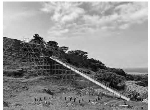
図7 今帰仁城跡附シイナ城跡 主郭石垣の復旧工事
