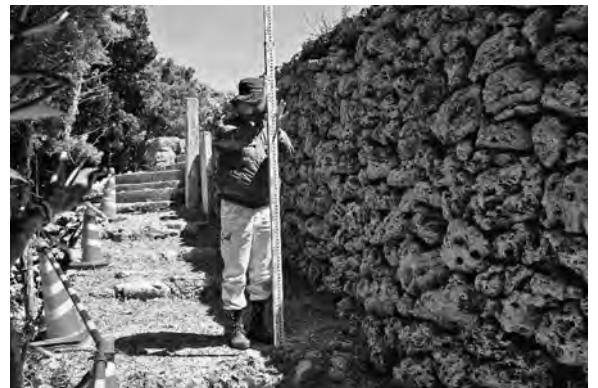
図3 先島諸島火番盛（小城盛） 石垣の測量状況
