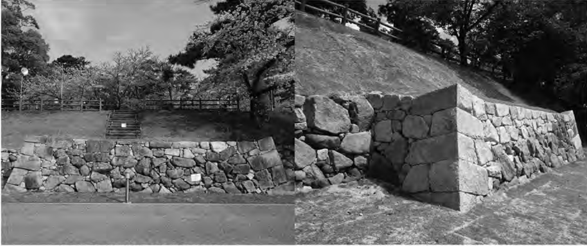
(令和2年度)岡崎城跡菅生川端石垣中央拵形石垣整備
