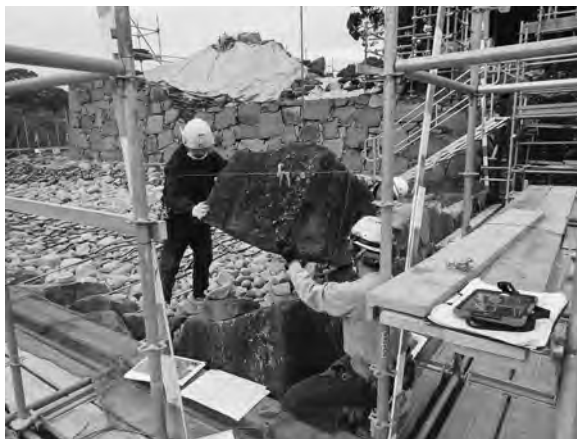
図7 熊本城跡 飯田丸五階櫓下石垣の積み直し
