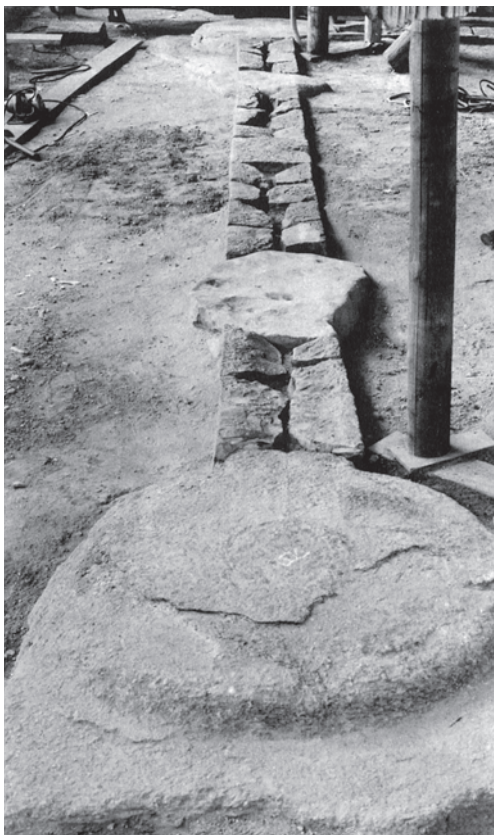
Fig.VIII-2-1 東大寺鐘楼 狭間石(東面) 北から
