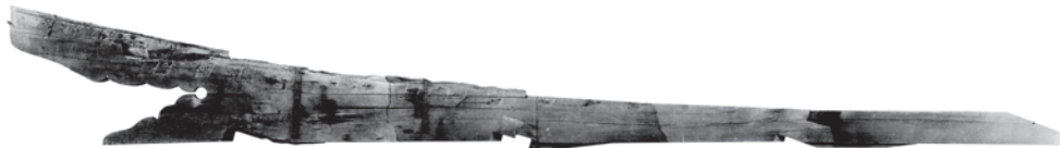
Fig.VIII-4-7 東大寺鐘楼 隅木 (南西の南方)
