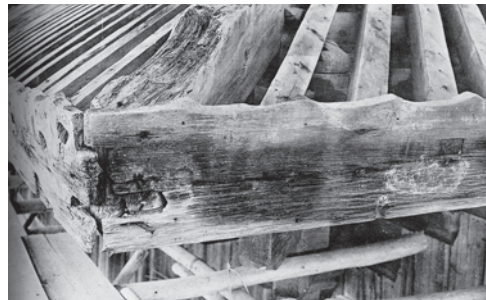
Fig.VIII-3-11 浄土寺浄土堂 鼻隠板 (隅)
