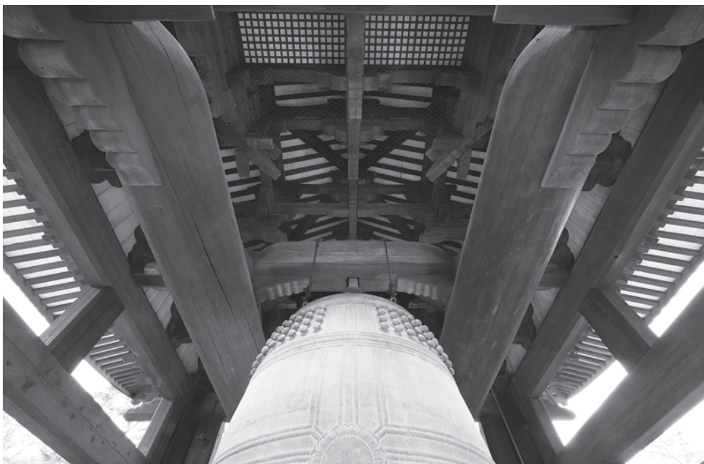
Fig.VIII-4-2 東大寺鐘樓 大虹梁と鐘釣虹梁(西から)
