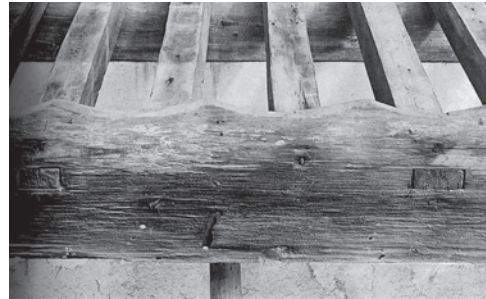
Fig.VIII-3-10 浄土寺浄土堂 鼻隠板 (平)
