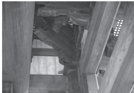
Fig.VIII-4-18 東大寺鐘樓 一の肘木鼻 (東から)
