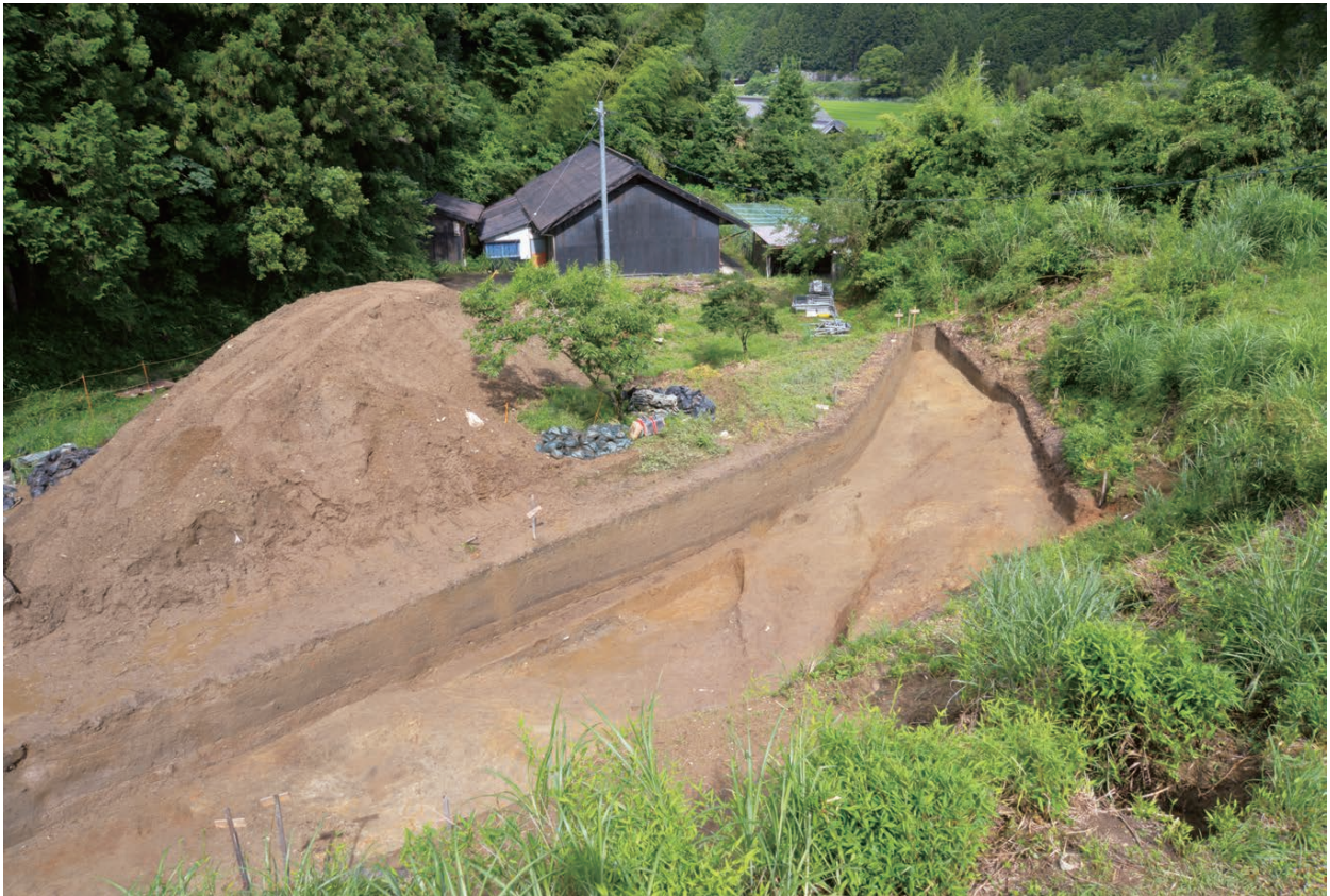
2・3区調査区南全景（北から）
