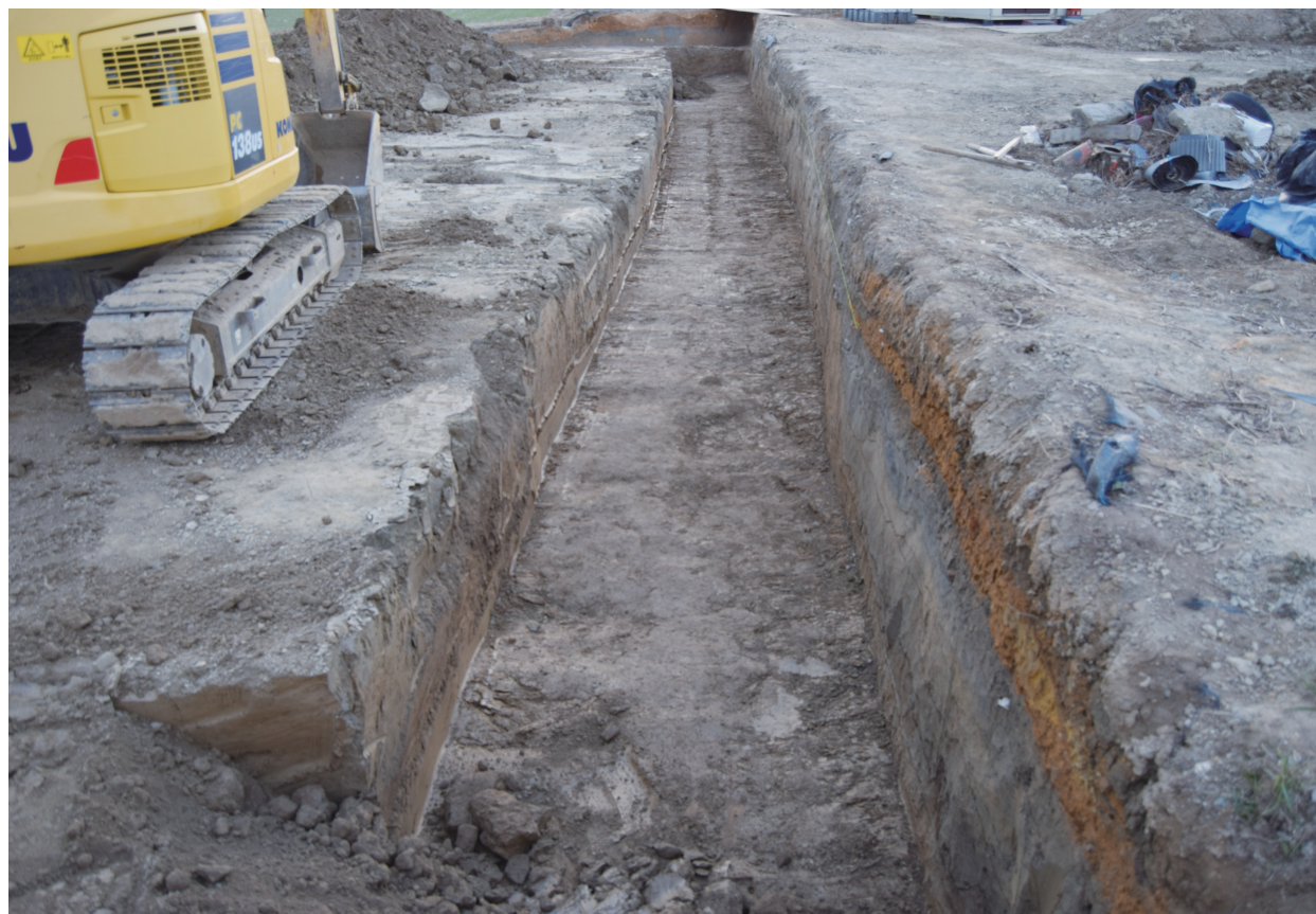
下層確認調査坑南壁（西から）
