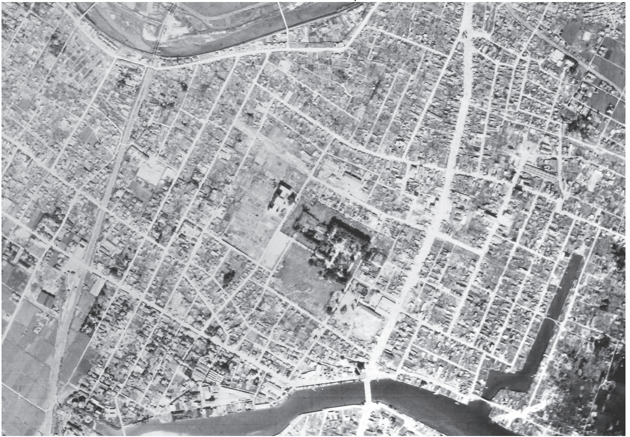
空中写真 (1947年9月米軍撮影、裁判所再建後) ※上が北
