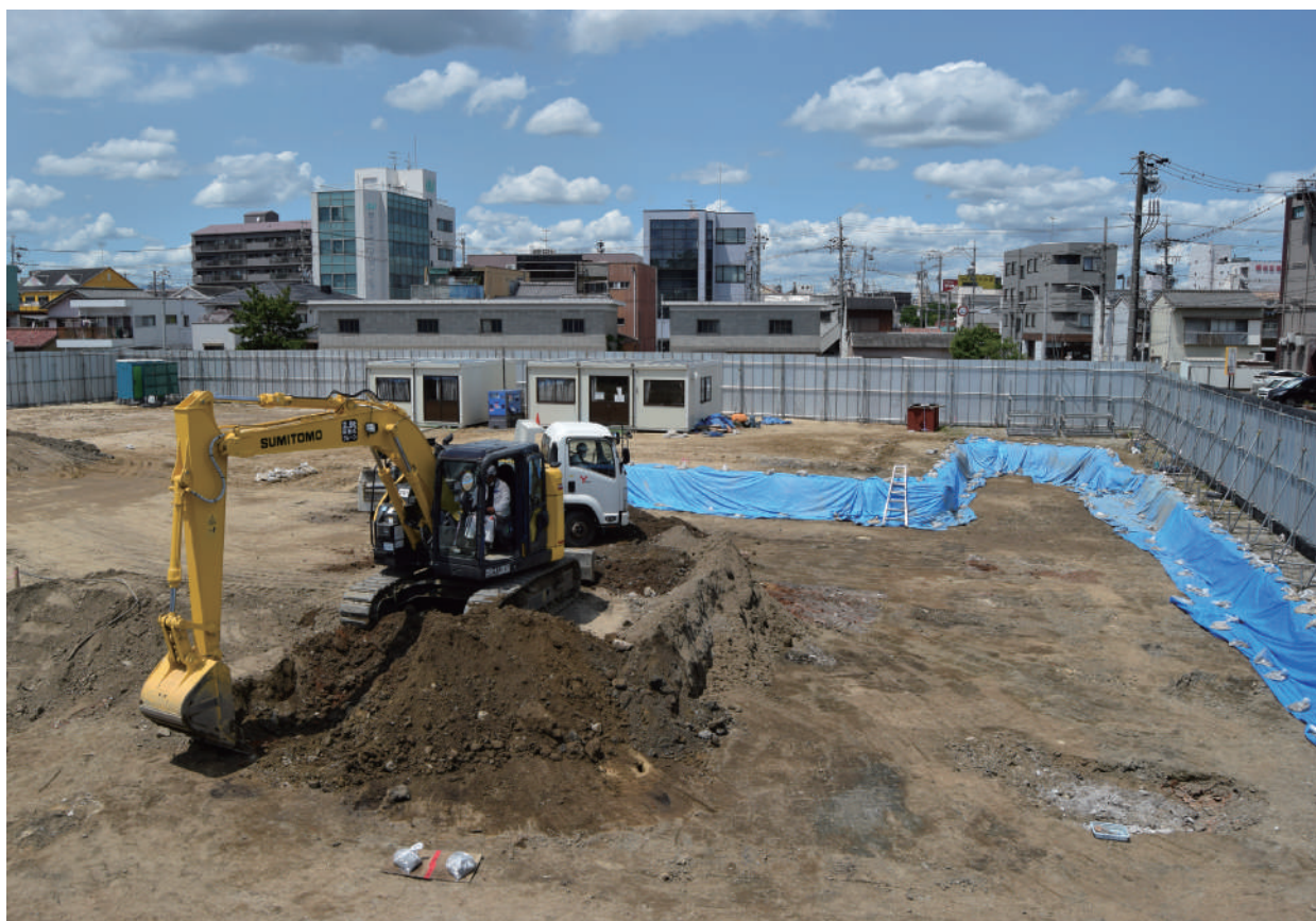
1区 表土掘削状況 (南西から)
