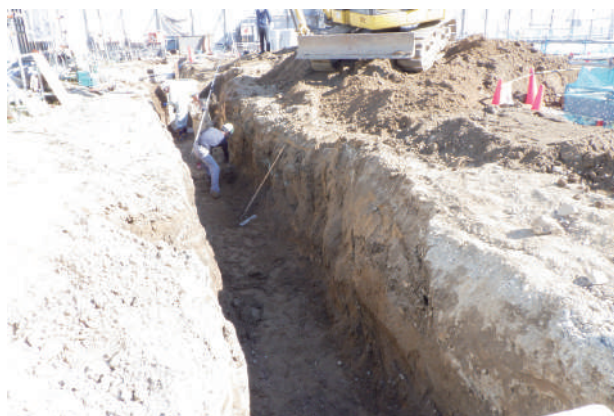
同 No1 作業風景 (西から)
