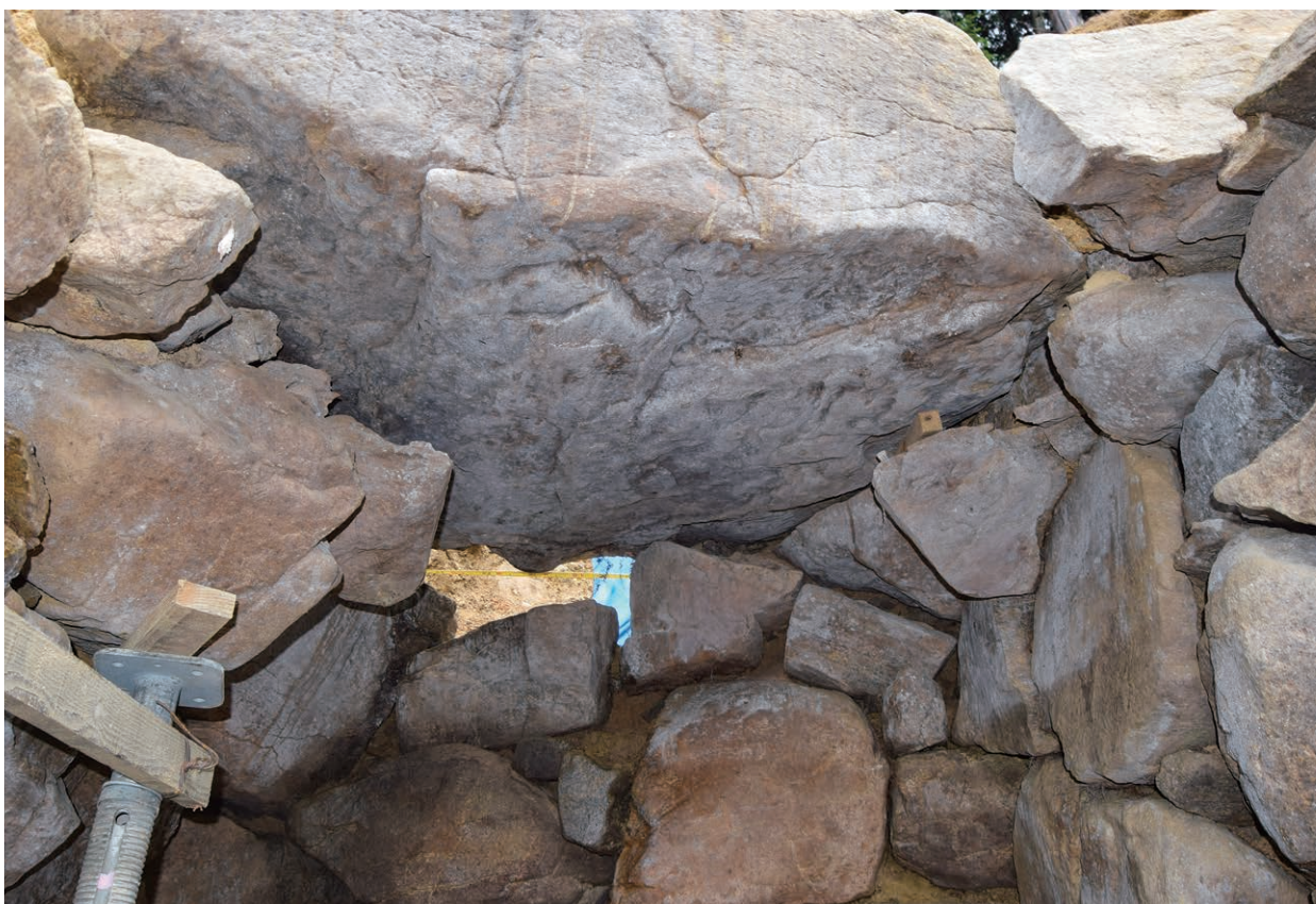
玄室天井石 (南から)
