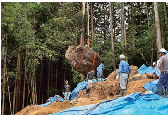
写真1 天井石撤去の作業風景
