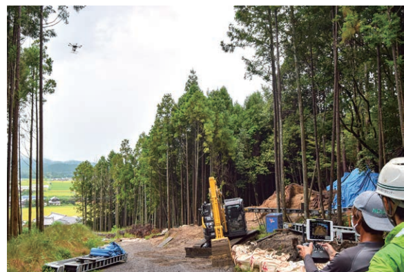
写真2 空中写真撮影の作業風景
