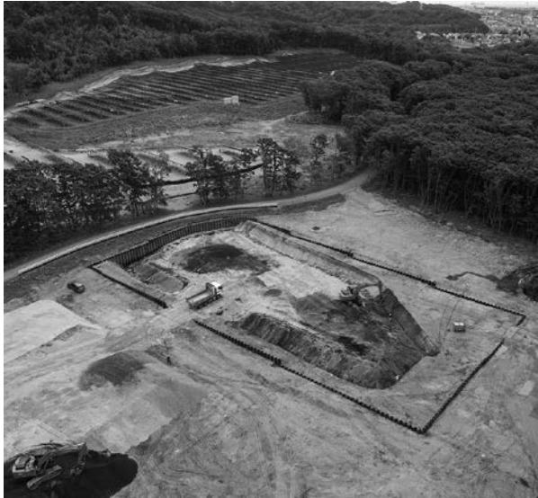
重機による表土除去作業 NW → SE
