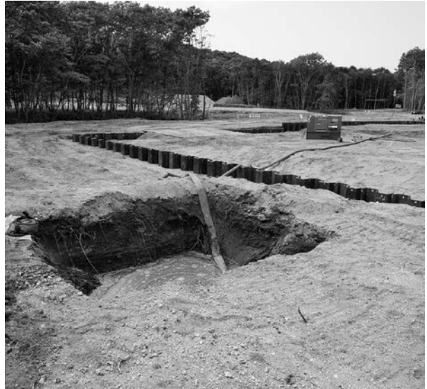
沈殿槽設置状況 SE → NW
