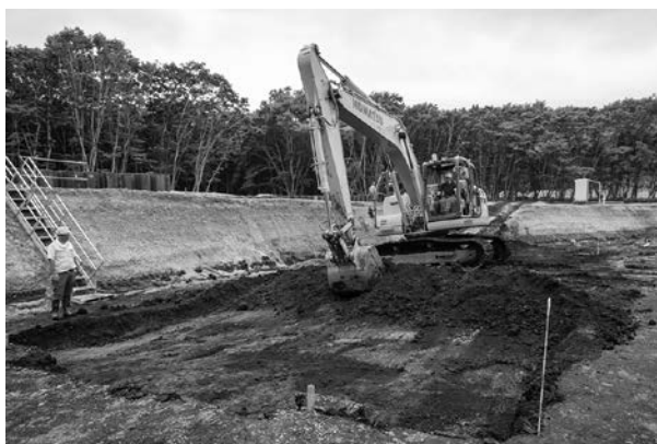
遺構確認調査 NE → SW
