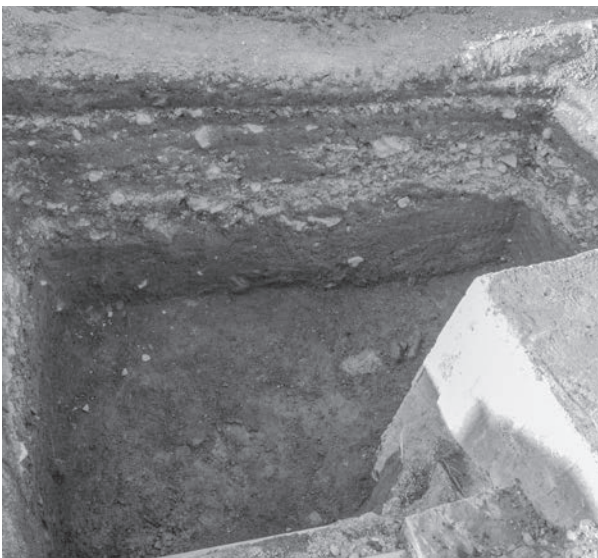
190cm掘削完了 地番 15-3 地先 南から
