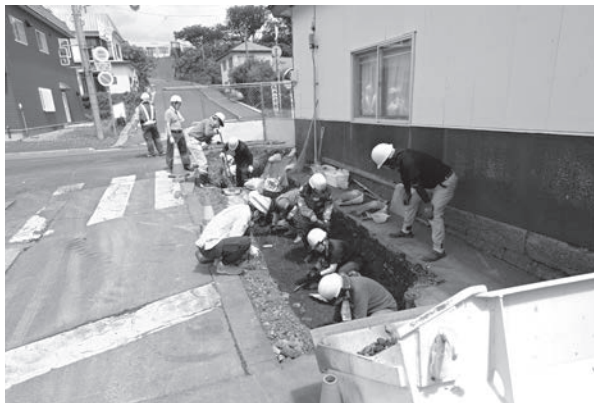
調査状況 南西から
