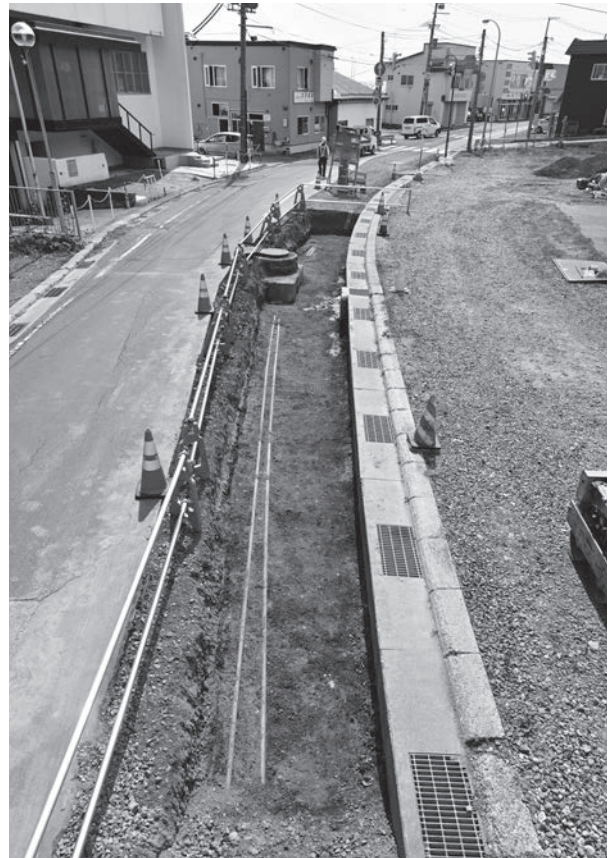
80cm掘削完了 地番 87 地先・88 地先 東から
