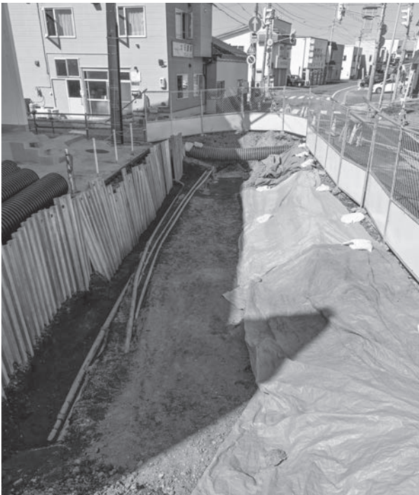
80cm掘削完了 地番 15-3 地先 東から
