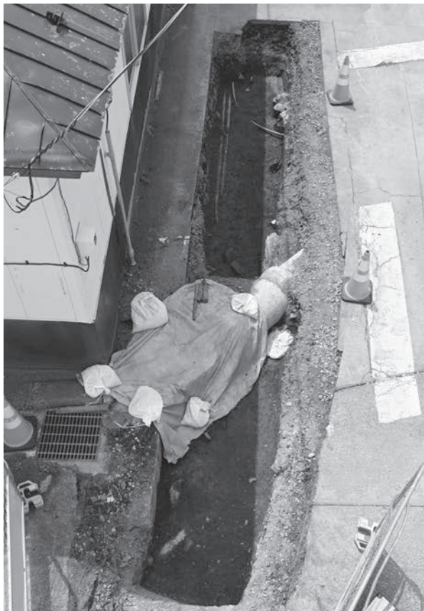
80cm掘削完了 北から
