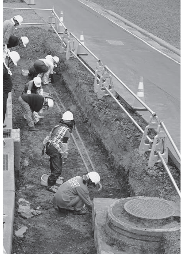
調査状況 地番 87 地先 西から
