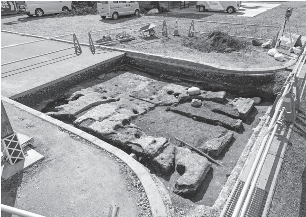
80cm 掘削完了 北東から
