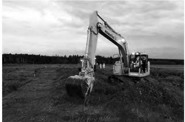
2 表土除去作業 (北東から)
