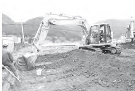
写真2 重機作業風景
