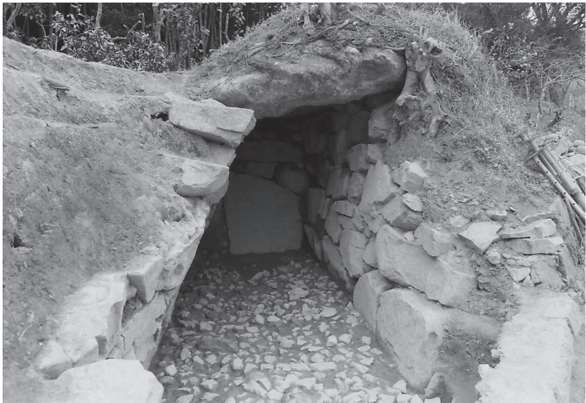
左側壁（南から）
