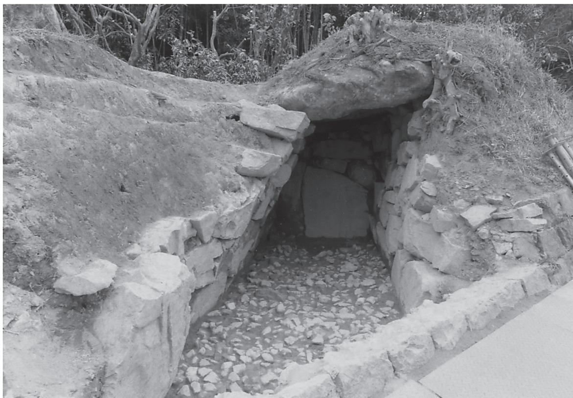
石室全景（南東から）
