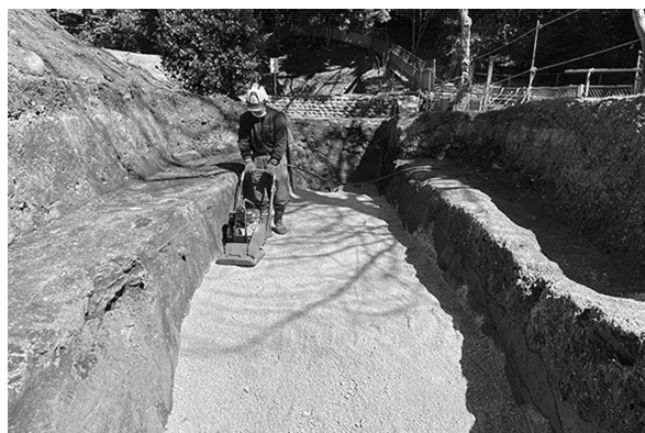
転圧作業（22A区）
