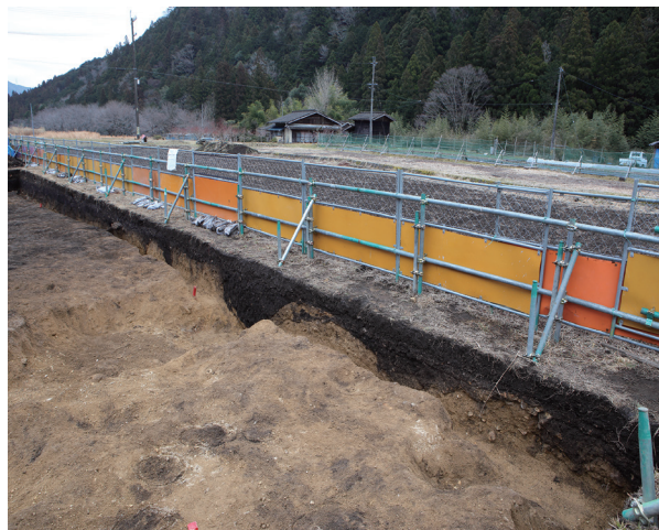
A区南壁（北西より）
