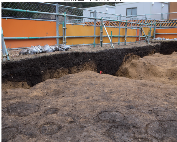
A区南壁西部（北東より）
