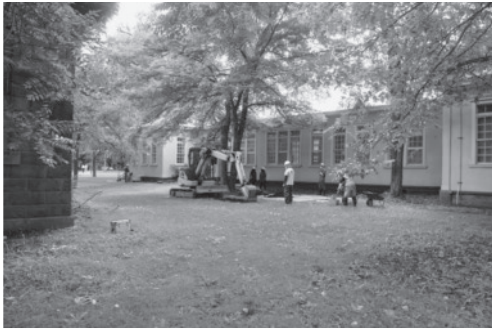
A. ワイン研修センター改修室外機基礎その他敷設工事（北西より）調査番号：2205
