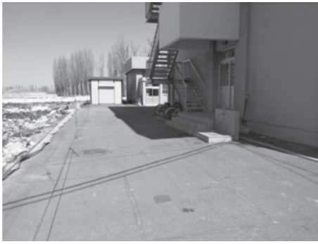
A. 確認調査前の状況（遠景：南より）
