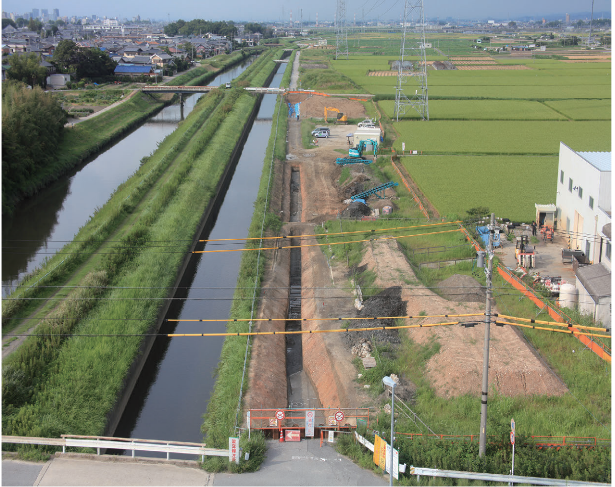
A区全景（南より）
