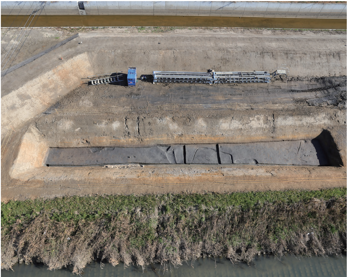
A区下面 (西より)
