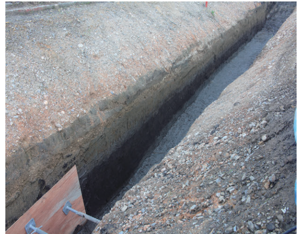
A 区 026NR 北岸 (南東より)
