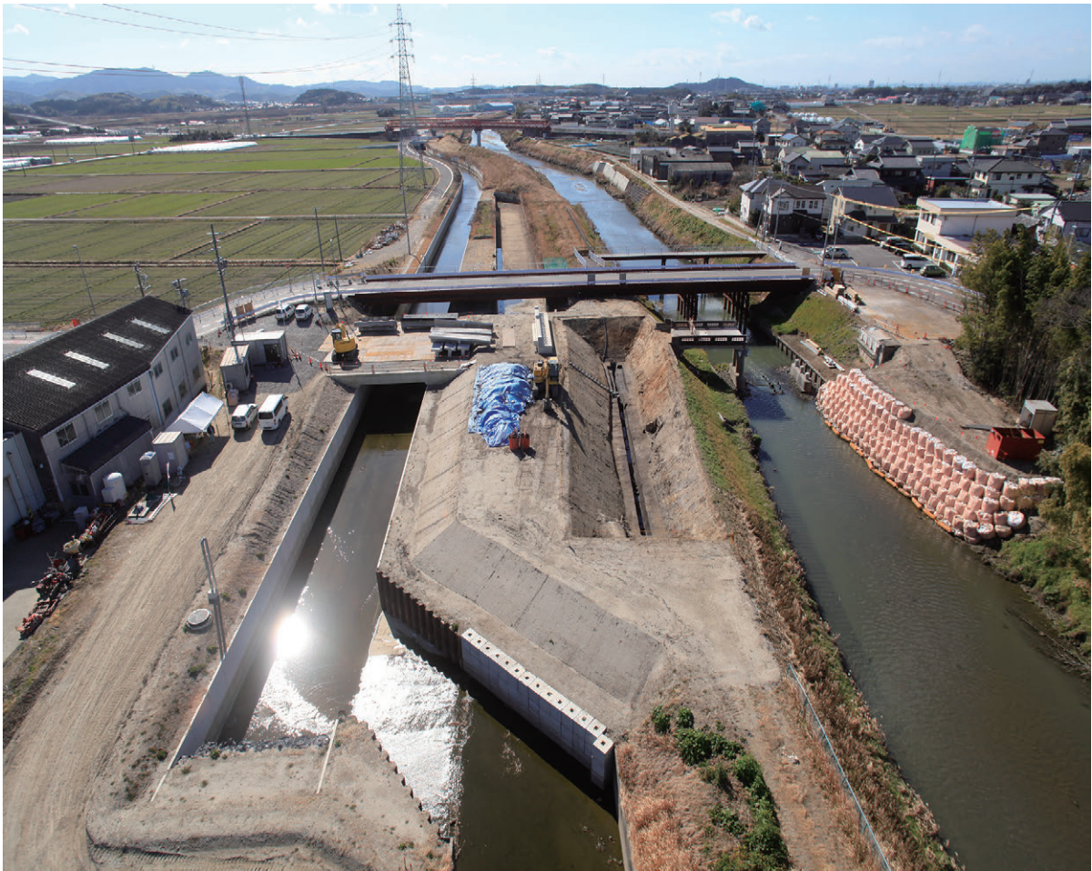
調査区遠景（北より）
