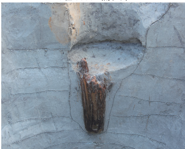
C 区 051SK 断ち割り状況 (南より)
