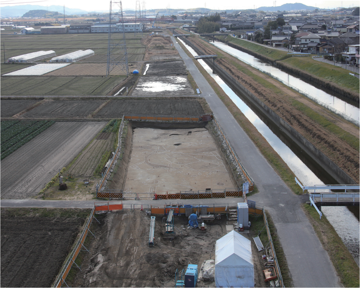
調査区遠景（北より）
