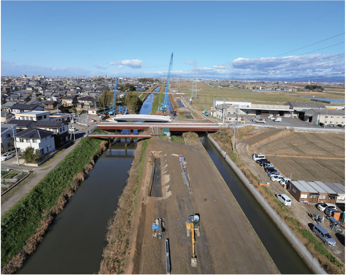
調査区遠景（南より）
