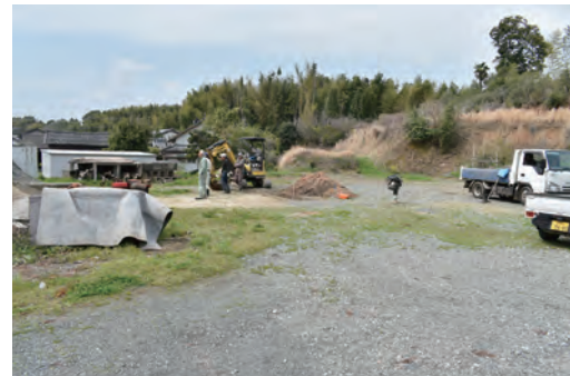
調査箇所全景
