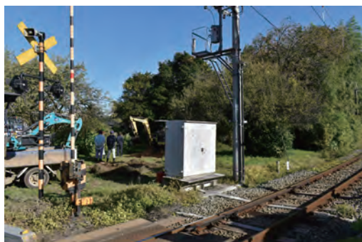
調査箇所全景
