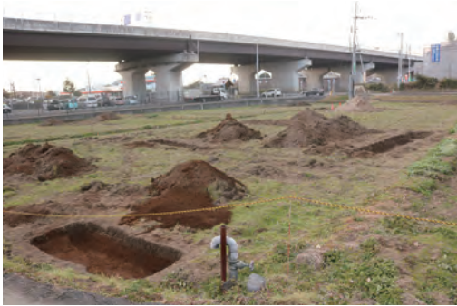
調査箇所全景 東より
