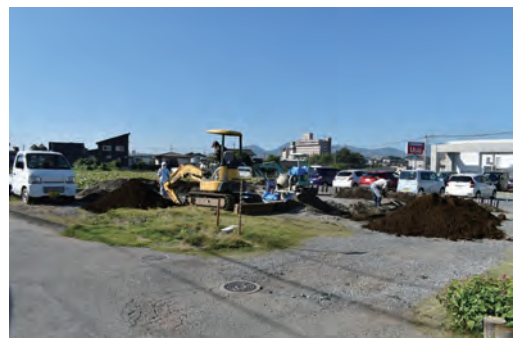
調査箇所全景
