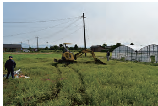
調査箇所全景
