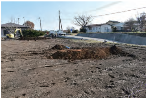
調査箇所全景
