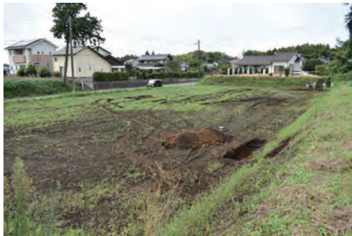
調査箇所全景
