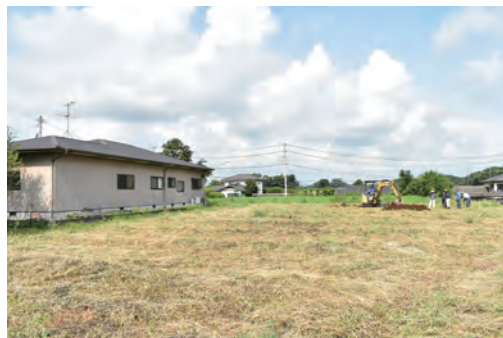
調査箇所全景
