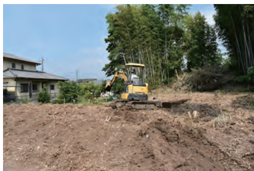
調査箇所全景
