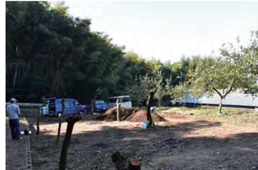
調査箇所全景
