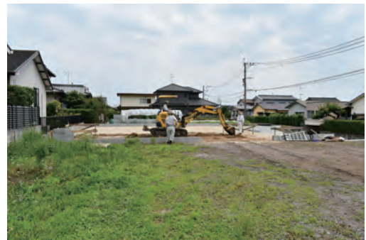
調査箇所全景
