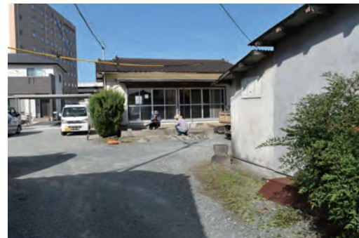
調査箇所全景
