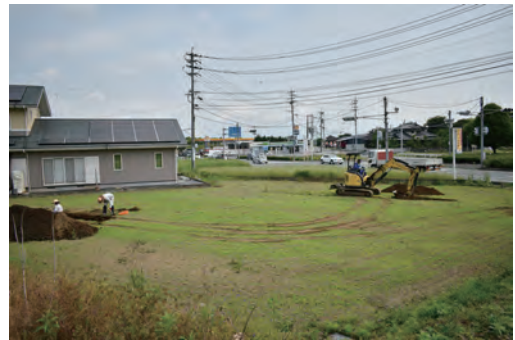
調査箇所全景
