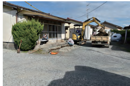
調査箇所全景
