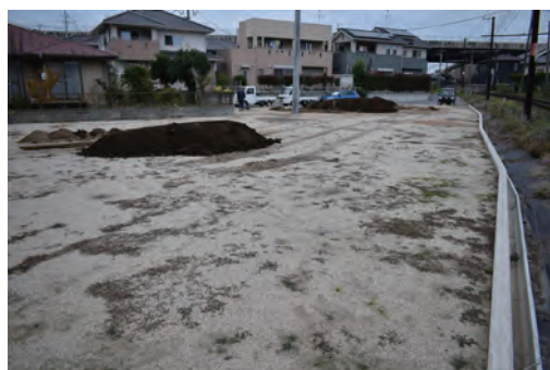
調査箇所全景
