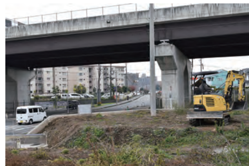
調査箇所全景
