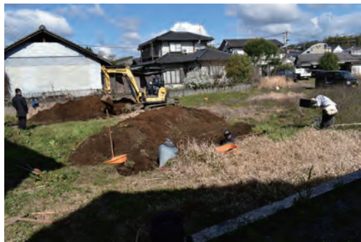
調査箇所全景
