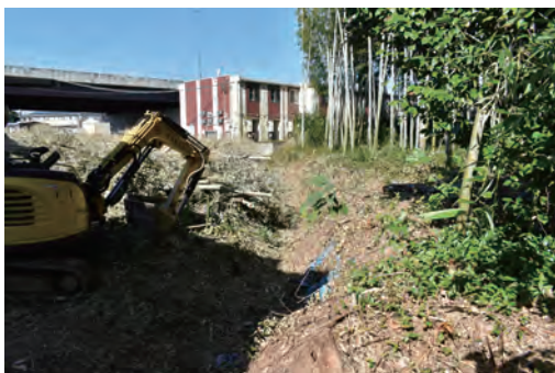
調査箇所全景
