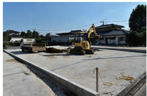
調査箇所全景
