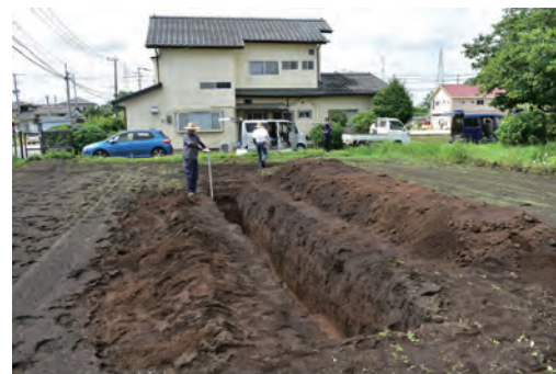
調査箇所全景
