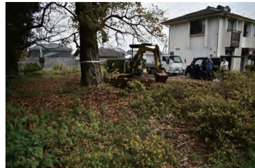
調査箇所全景
