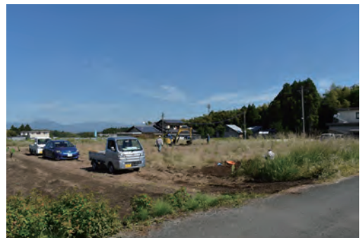
調査箇所全景
