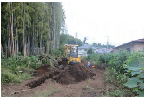
調査箇所全景
