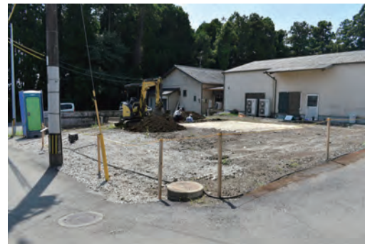
調査箇所全景
