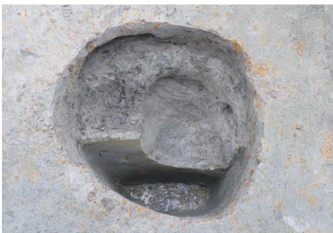
SB8306-P8274 完掘(南から)
