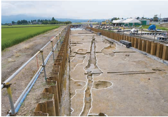
SD8082 (奥)・8095 (手前) 完掘 (東から)
