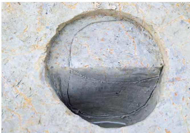
SB8308-P8290 断面(南から)
