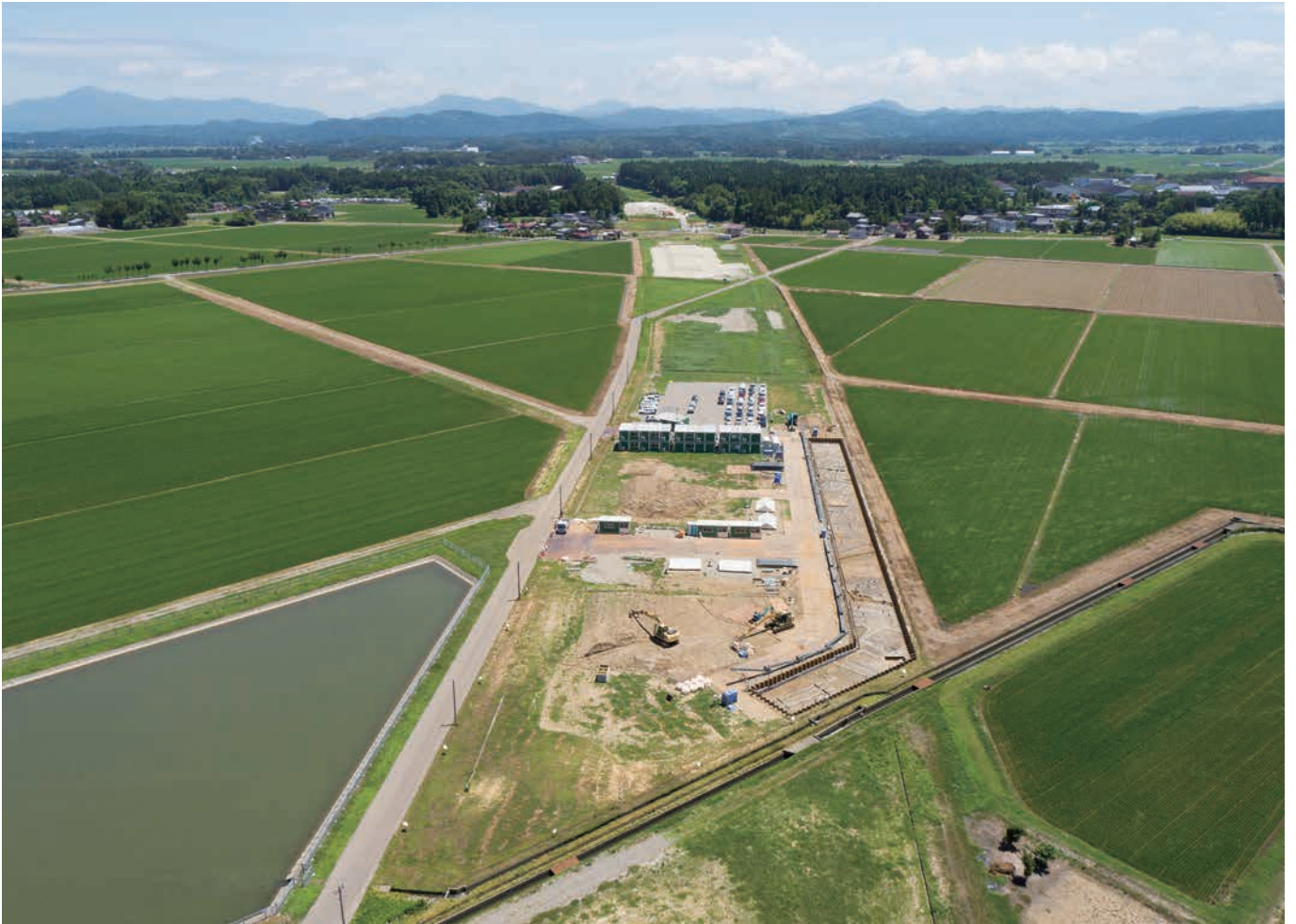
市道区・東区 遠景（南西から）
