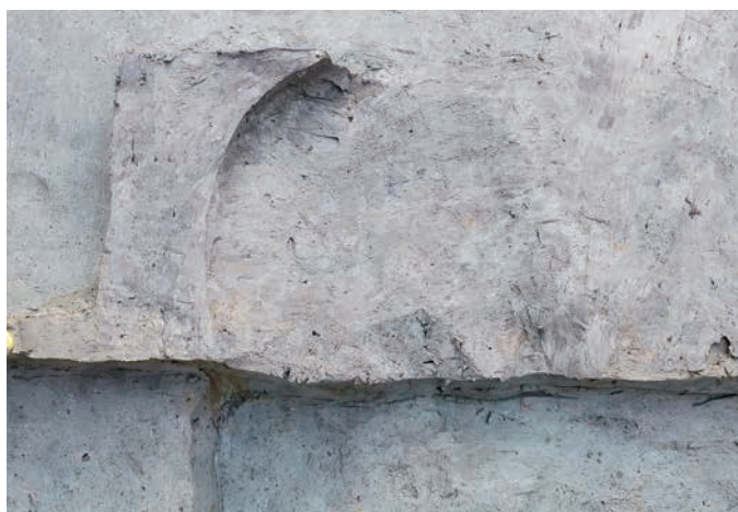
P8807 完掘(東から)
