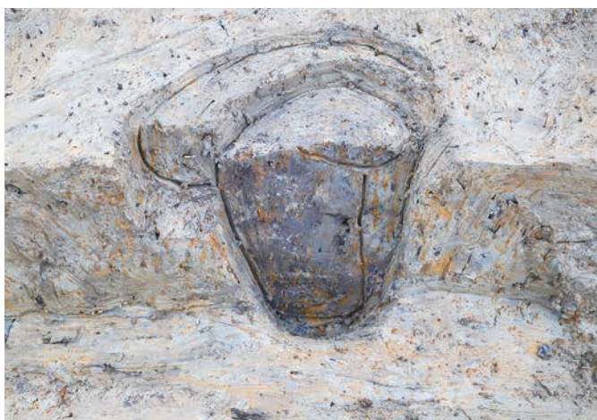
SB9052-P6 断面(西から)
