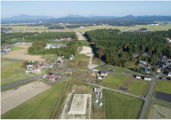
東区 遠景（西から）
