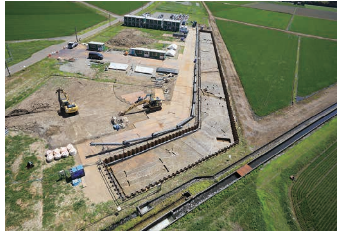
第1面 全景(南西から)
