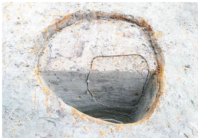
SB8306-P8274 断面(南から)
