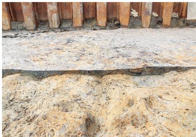
SX8100 断面 (南から)
