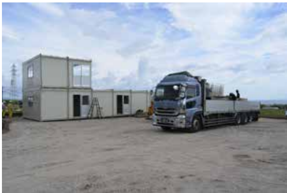
機材等搬入状況
