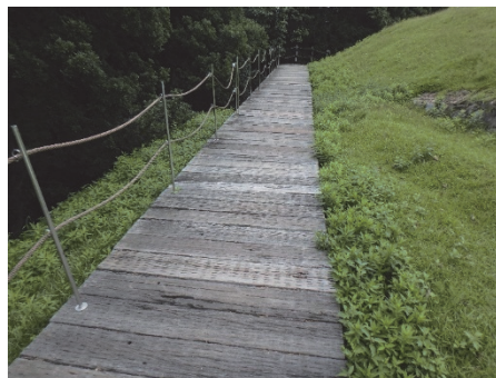
図 45 木道の事例 (妙見山古墳・愛媛県今治市)
