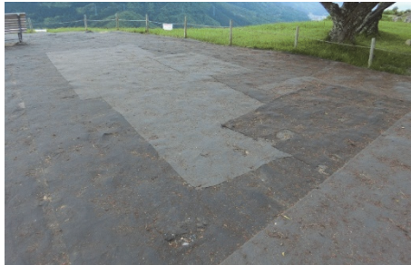
図 49 防草シートの整備事例 (竹田城跡・兵庫県朝来市)
