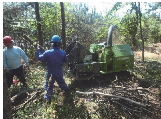
写真 35 移動式チッパーによる枝条の現場破碎
