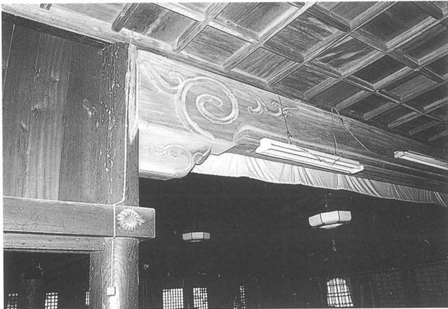
写真22 聖徳殿前殿内陣背面柱切断後に挿入した虹梁
