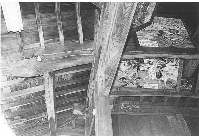
写真283 拝殿内部虹梁の先端(菖蒲桁となる)
