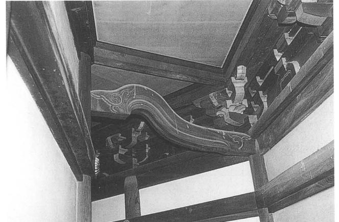
写真39 聖徳殿後殿側通り架構・組物
