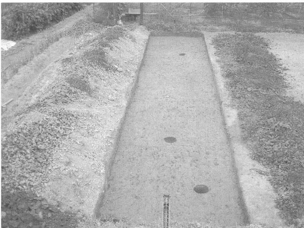
図15 1トレンチ全景 (西より)
