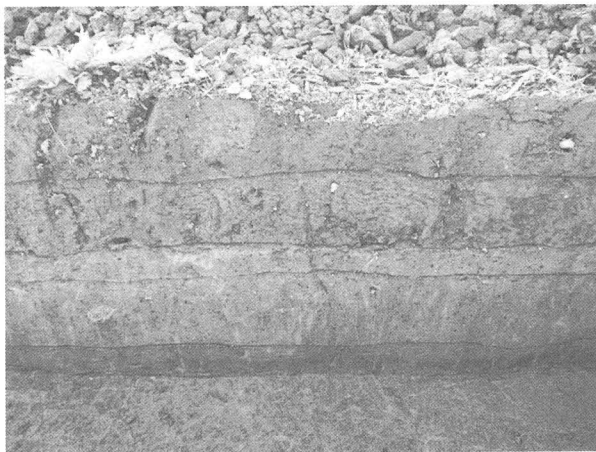
図57 No.6 トレンチ
