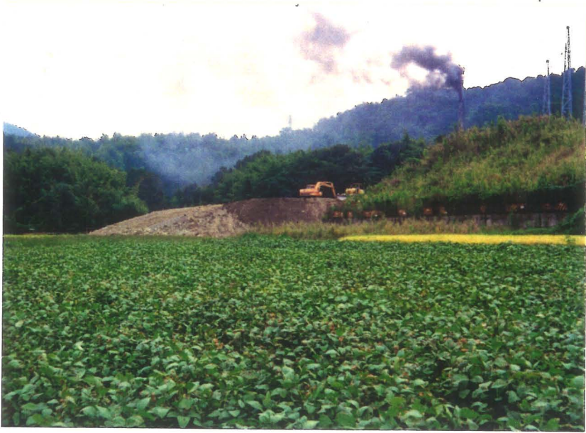
調査地遠望（西から）
