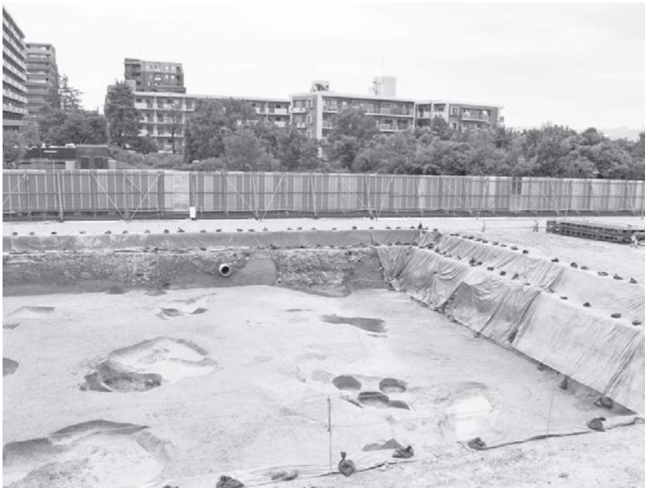
古池検出状況 〔調査区1/北西から〕 奥：残存する古池
