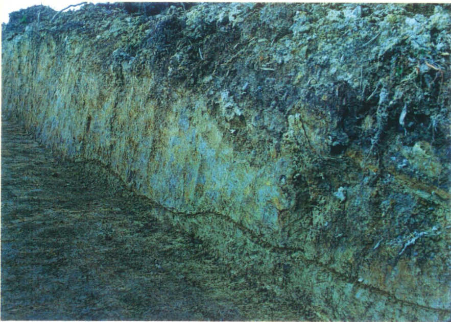
T-30土層（浚渫盛土部分）
