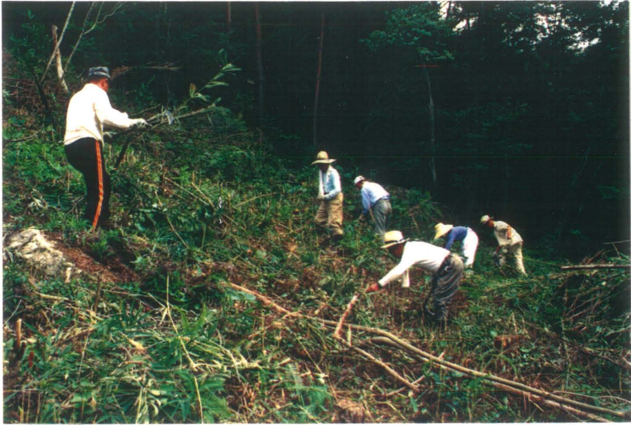
伐開作業風景
