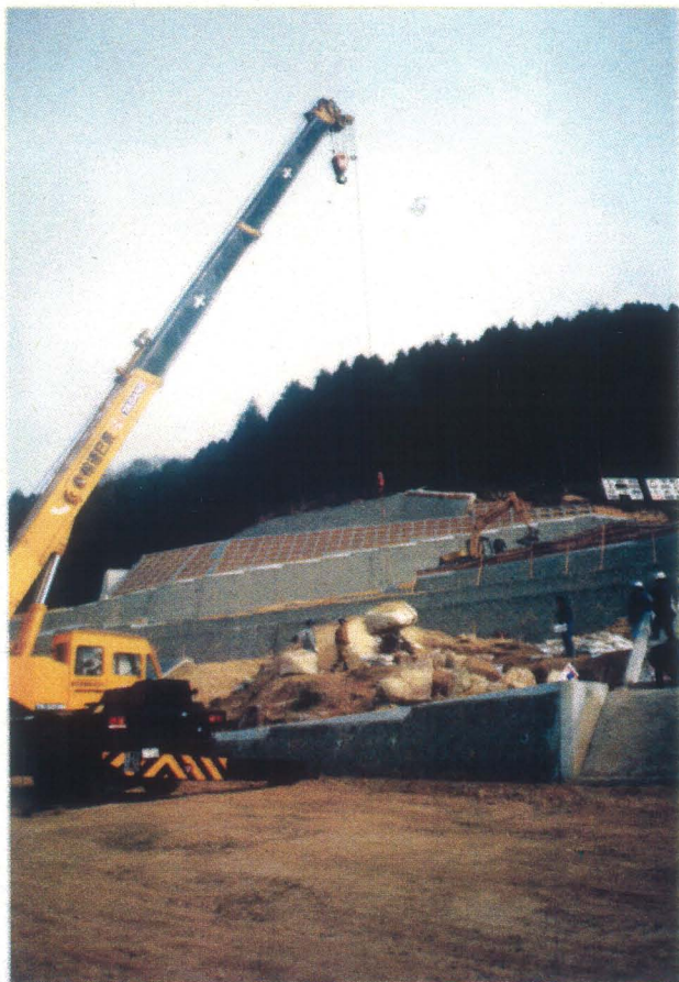
復元作業状況（レッカー車による石材の吊上）
