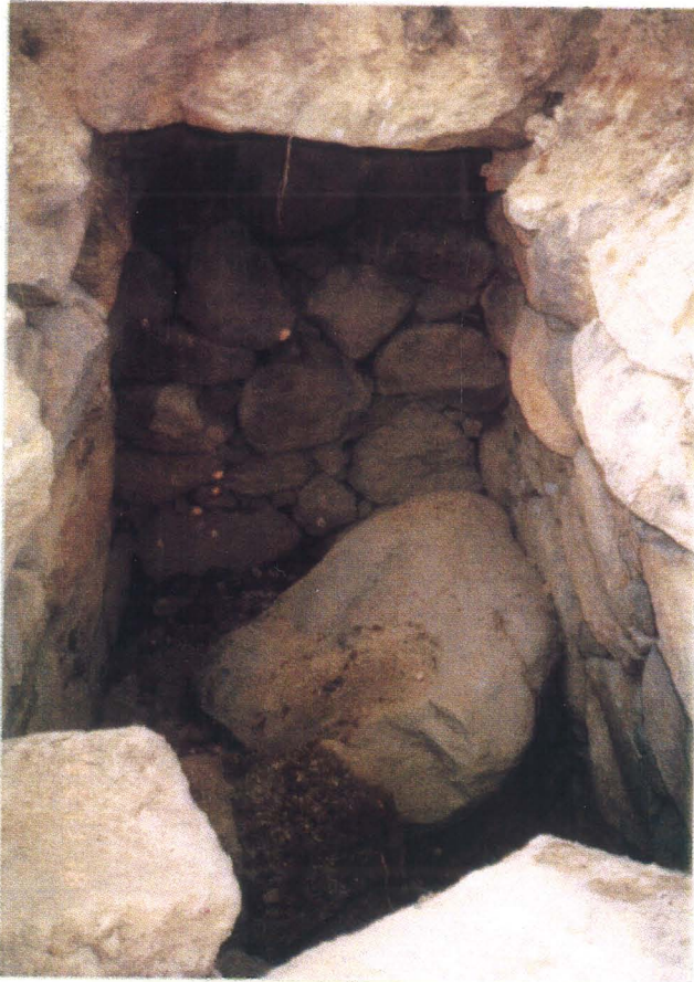
同石室内天井石落下状況（南から）
