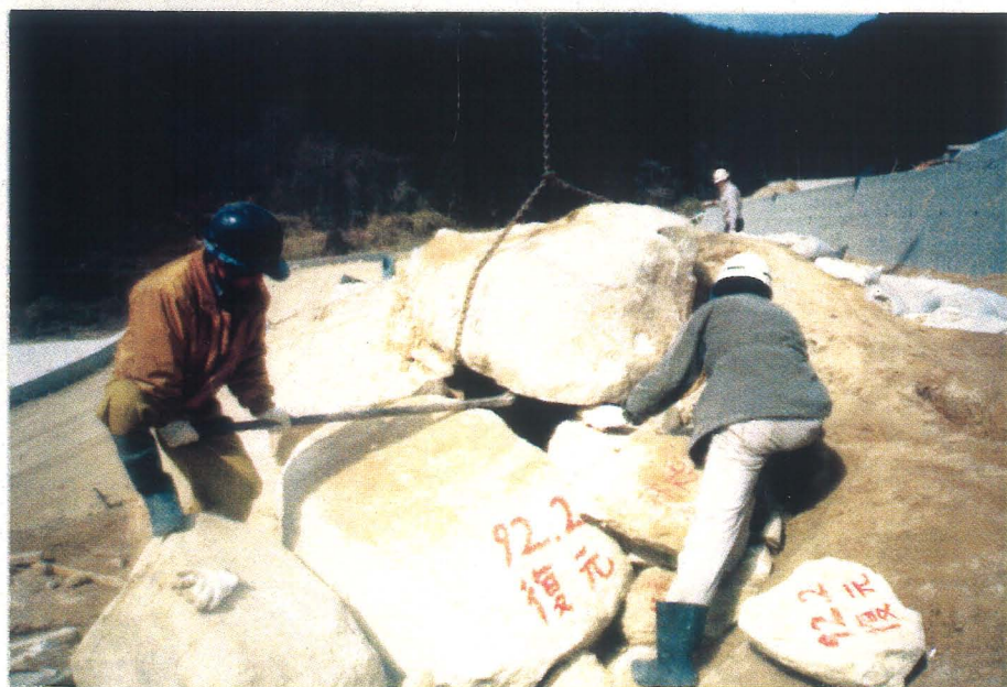
復元作業状況（石材据付作業状況）
