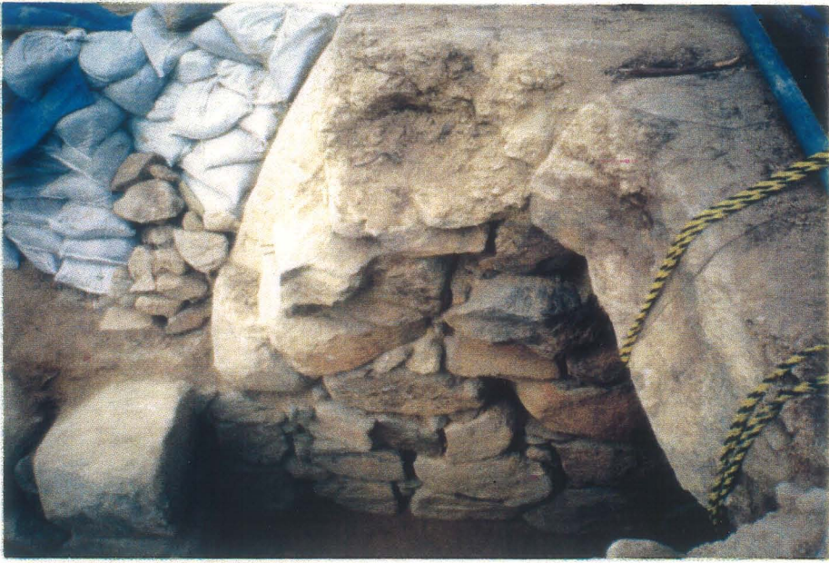
玄室右側壁面袖部崩落状況（東から）
