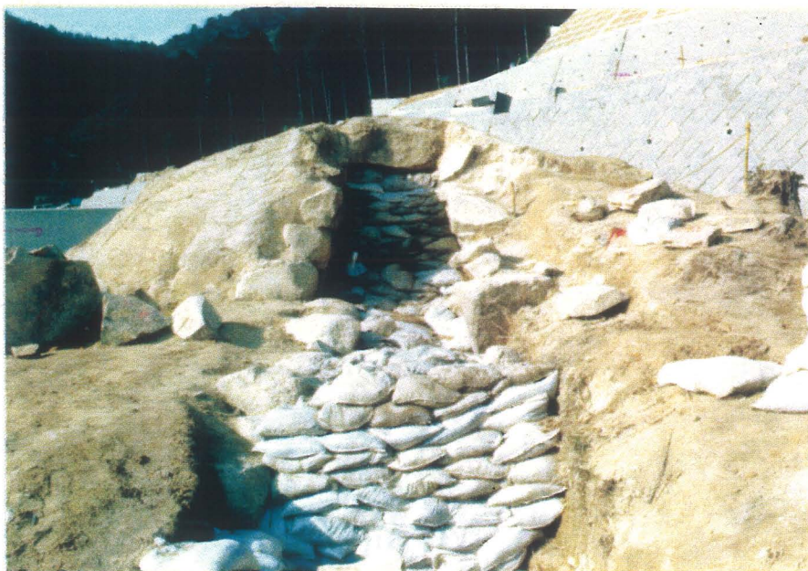
復元作業状況（石室内埋戻完了状況）
