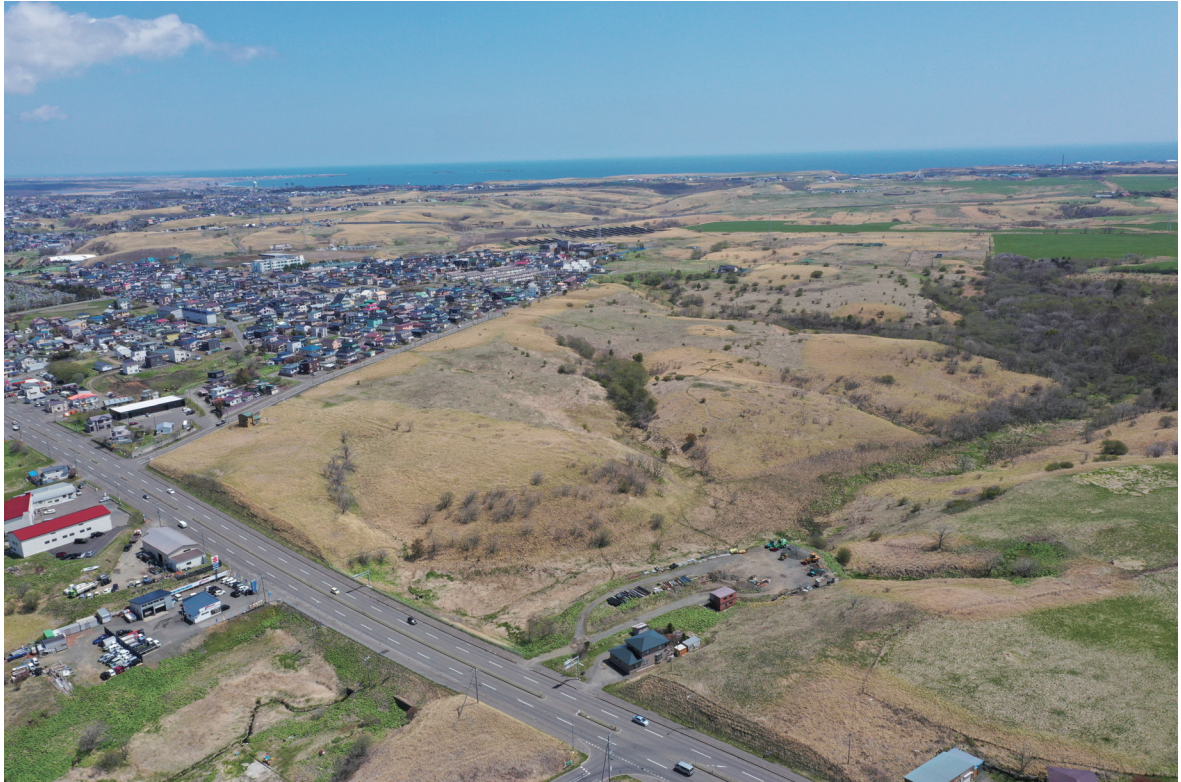
1 遺跡遠景 北西から 手前の道路は国道 44 号線 奥は太平洋
