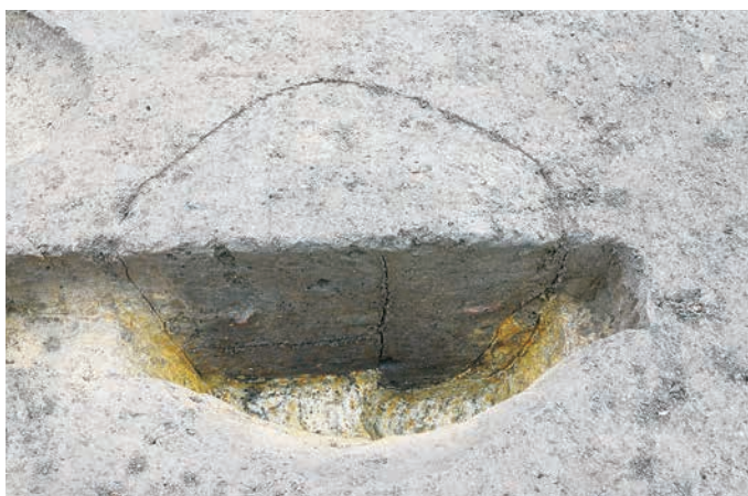
Pit103 (SB406) 断面(南→北)
