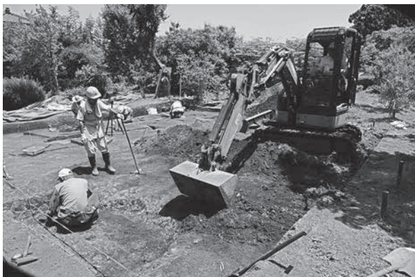
2区の表土掘削
