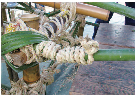
写真8 骨を折り曲げる部分を縄で補強
