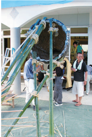
写真 11 面の取り付け部分
