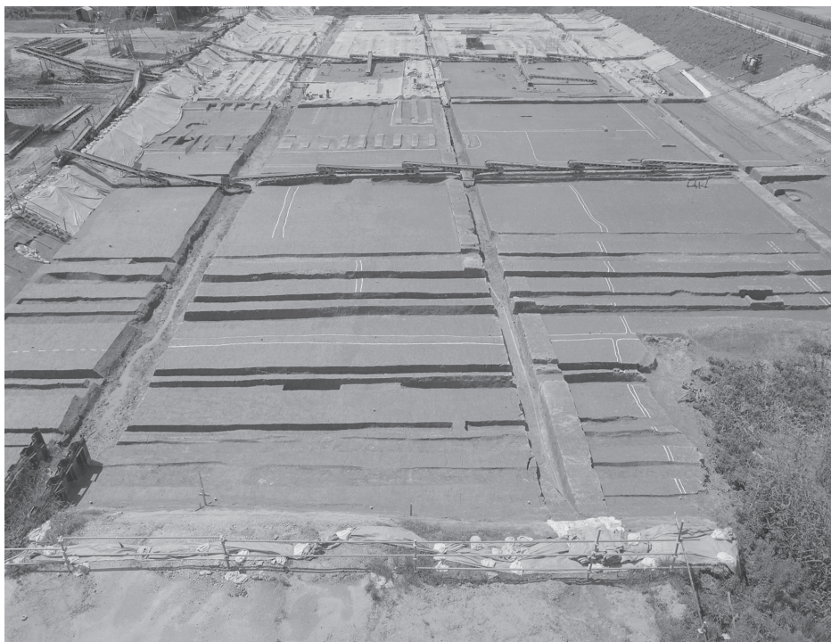
1 1区 第3-2a面 検出状況 (北から)
