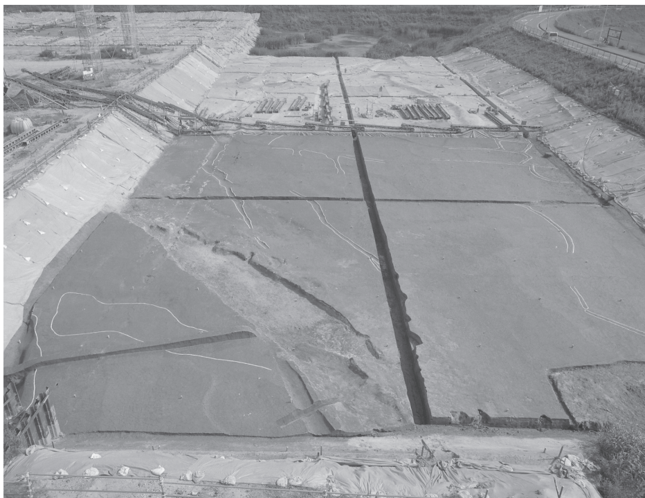
1 1区 第13-1a面 検出状況 (北から)
