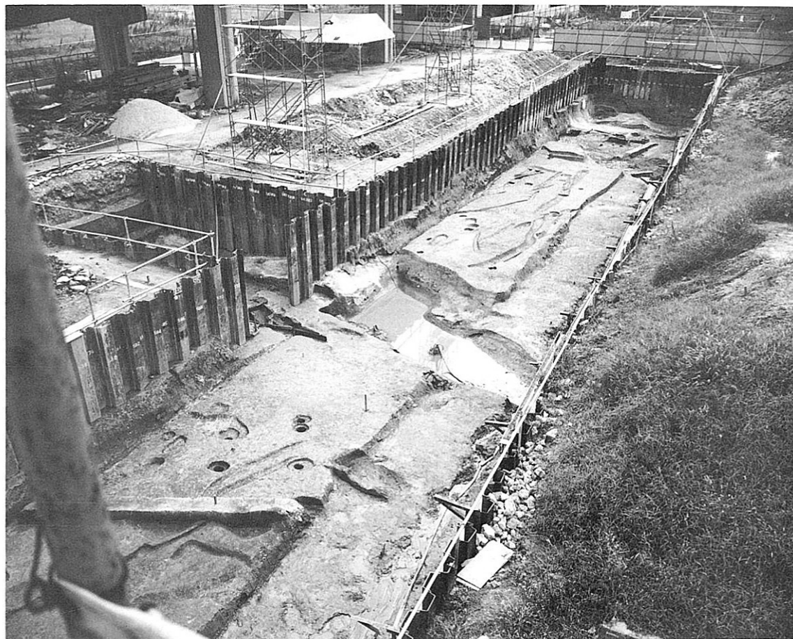
溝S D45・46 (←北西)
