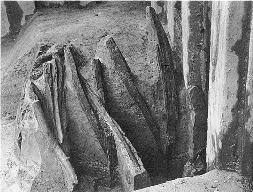
最下層護岸杭 (←北)
